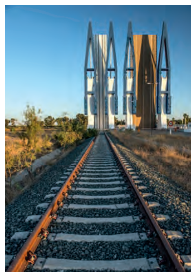
Puentes móviles con viales de carretera y ferrocarril.
