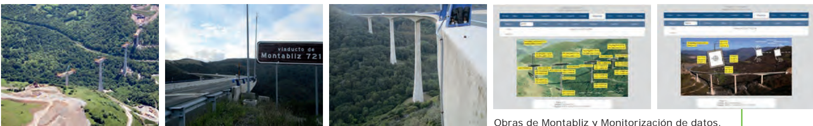
Obras de Montabliz y Monitorización de datos.
