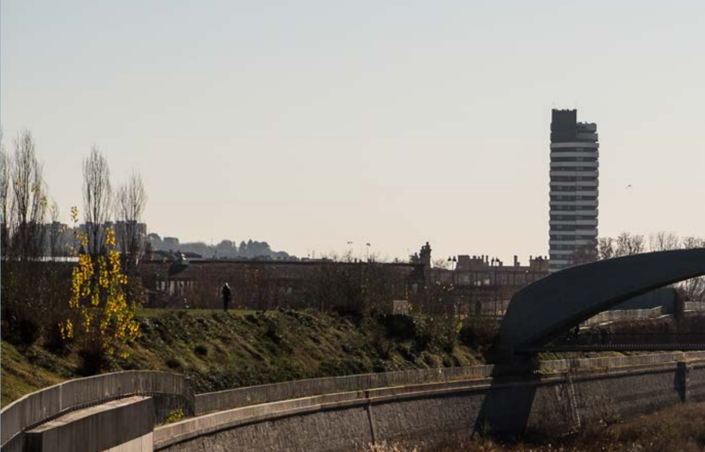
Perspectiva de los puentes gemelos del Invernadero y del Matadero (2010) que cuentan con sendas bóvedas de hormigón muy ligeras.
