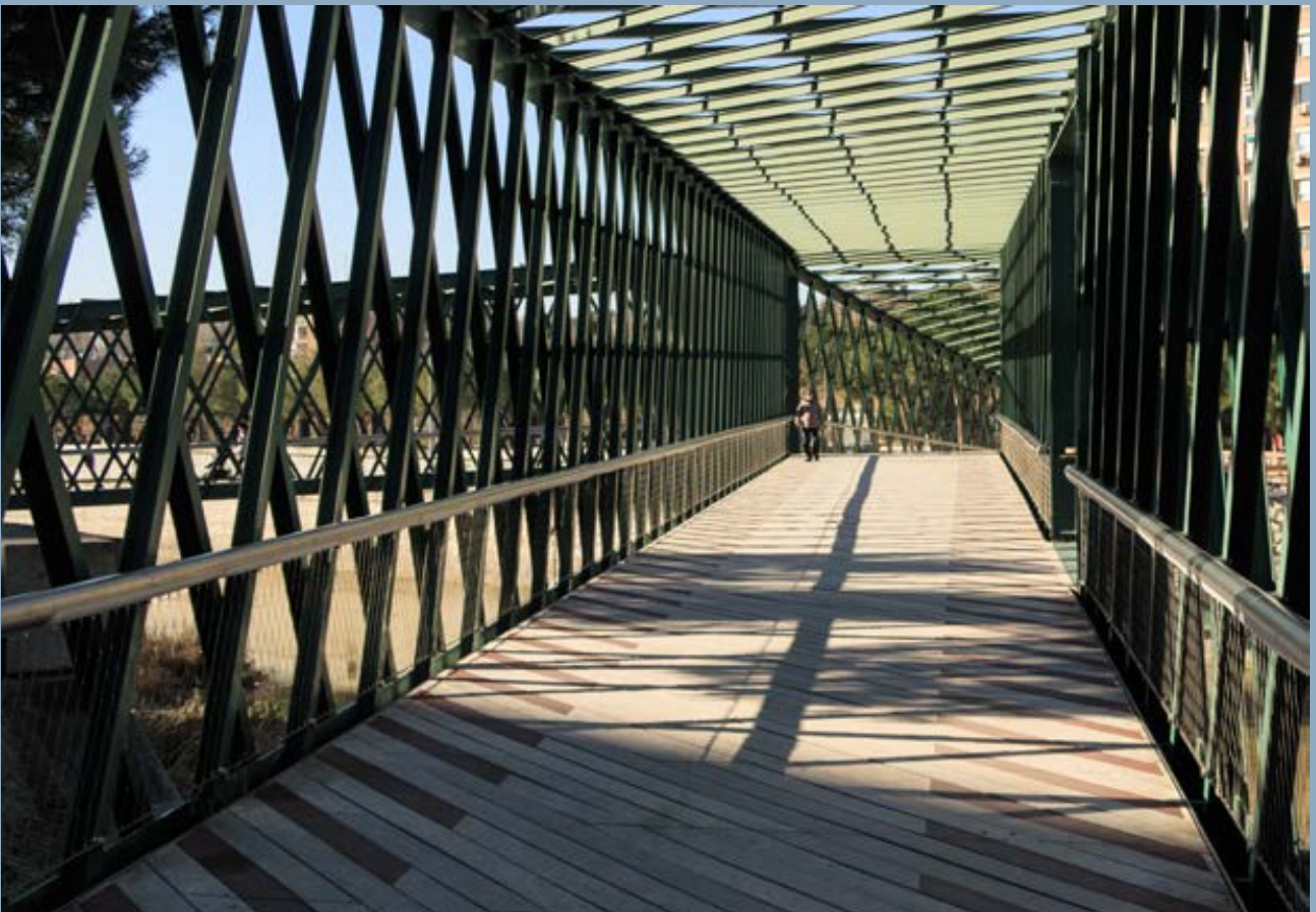
Puente del Principado de Andorra (2009), construido a imitación de los puentes ferroviarios del siglo XIX.
