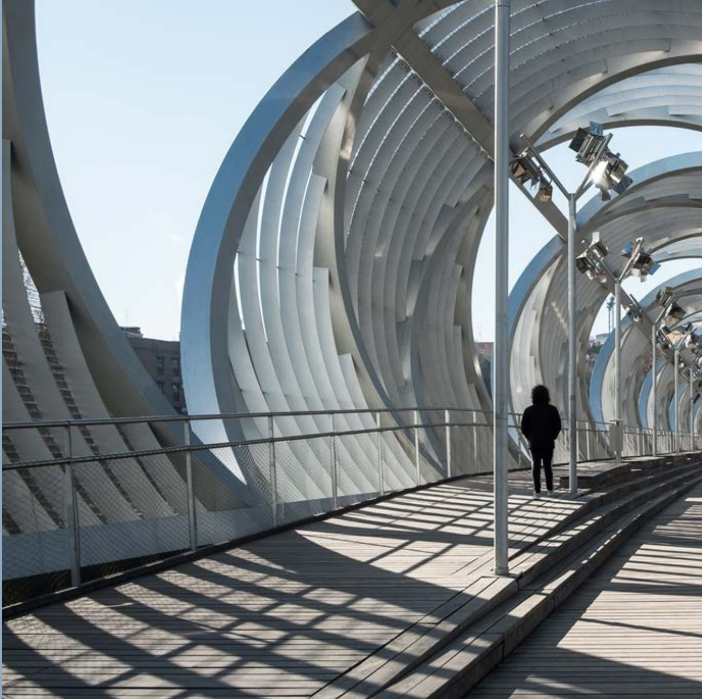
Puente Monumental de la Arganzuela, vista del interior con dos niveles en el tablero, uno para peatones y otro para bicicletas.
