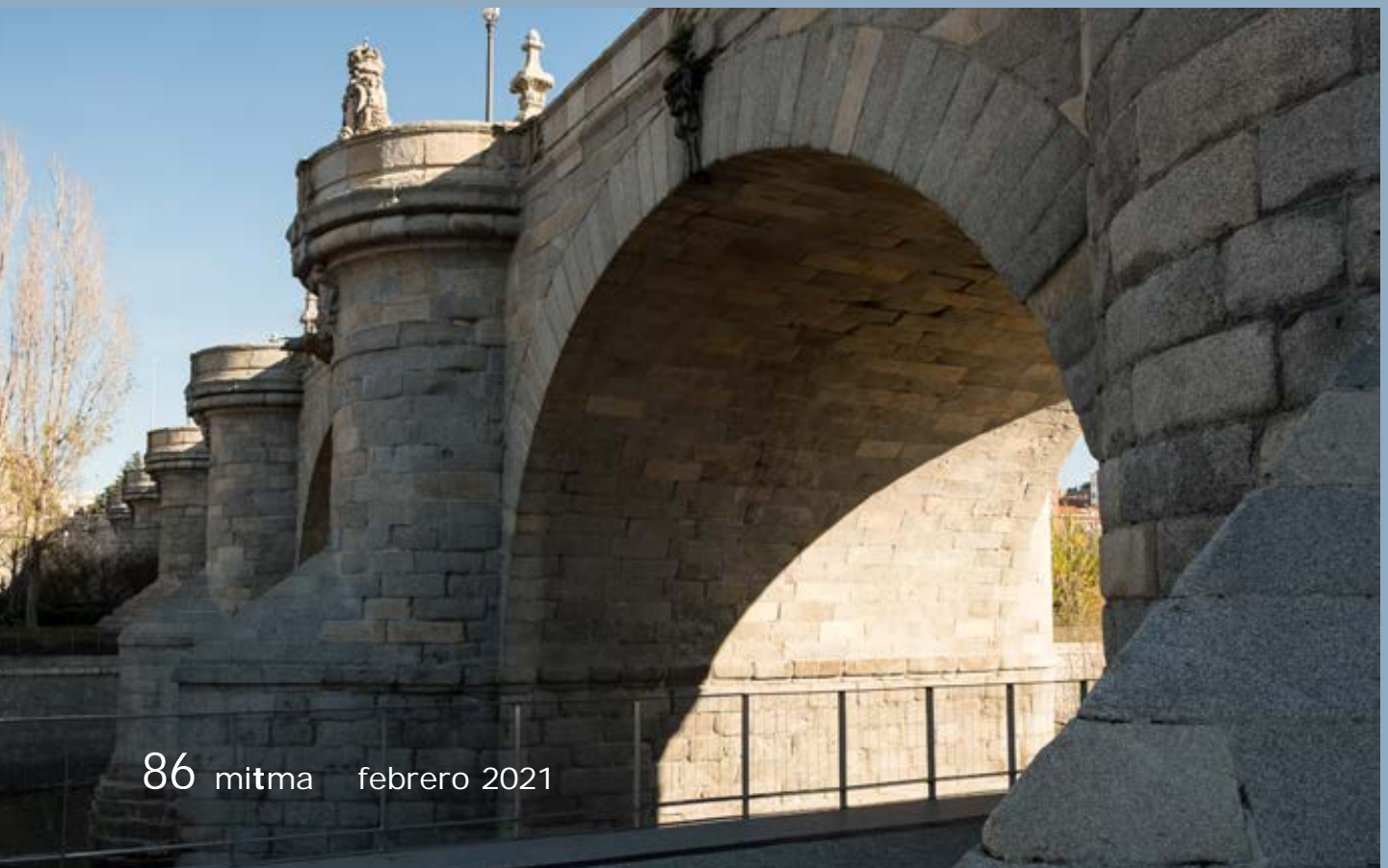
Vista del puente de Toledo (1732), proyectado por Pedro de Ribera.
