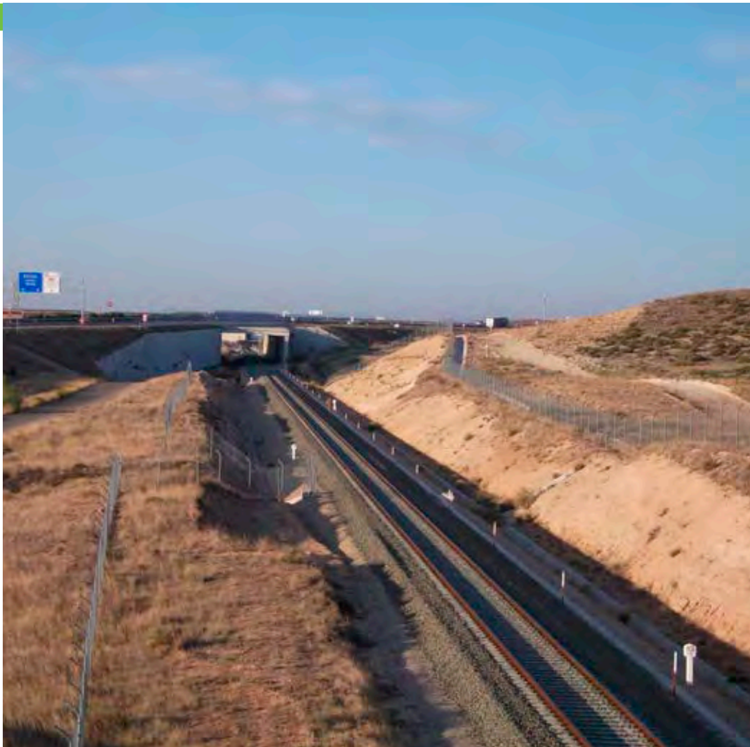
Paso superior (pérgola) de la A-23 en el P.K. 105+600. (T.M. de Zaragoza). Via dirección Teruel.
