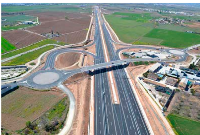
Enlace de la Variante Exterior con la carretera GR-3417 "Atarfe-Albolote".
