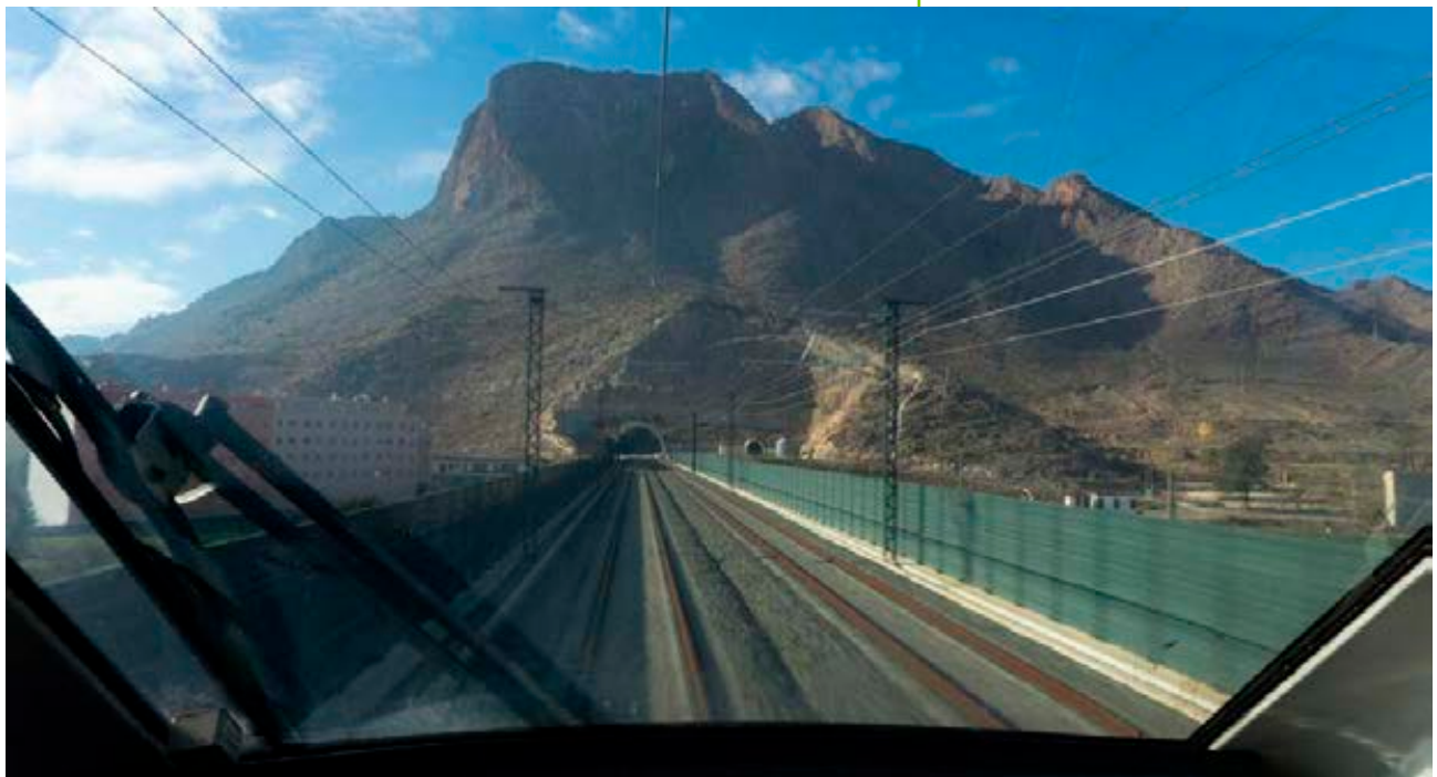
Túnel de Callosa.
