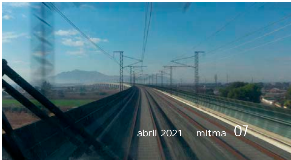
Viaducto sobre la AP-7.
