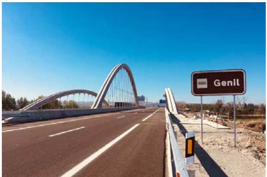
Viaducto sobre el río Genil.
