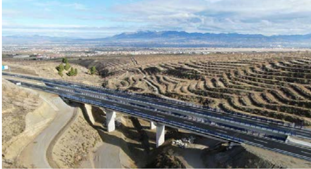
Viaducto de Cañada Honda.
