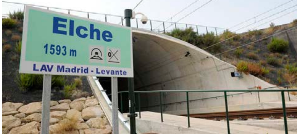
Una de las bocas del túnel de Elche.
