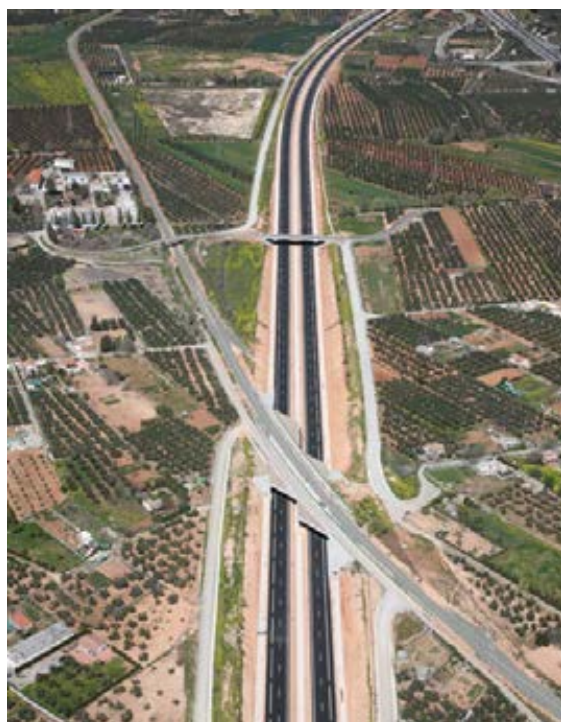
Paso inferior bajo el ferrocarril Almería-Granada.
