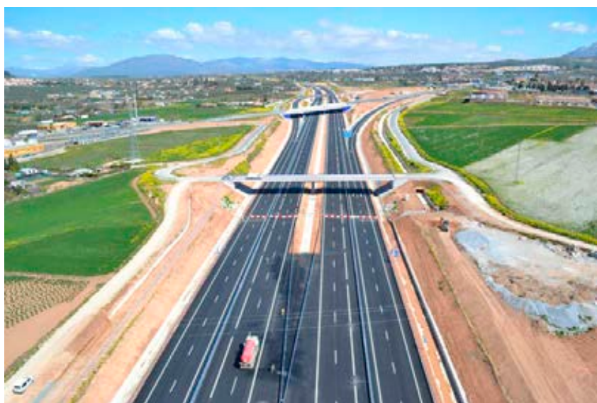
Inicio del Tramo 2.
