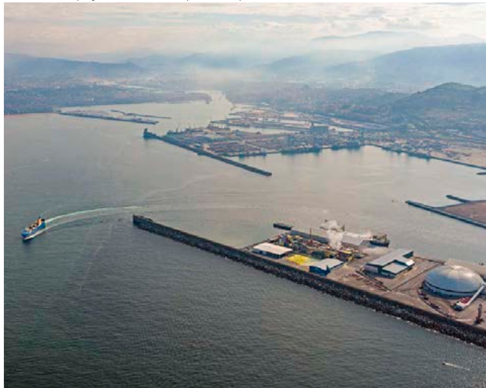
Salida de un buque junto al muelle AZ1 que será ampliado.
