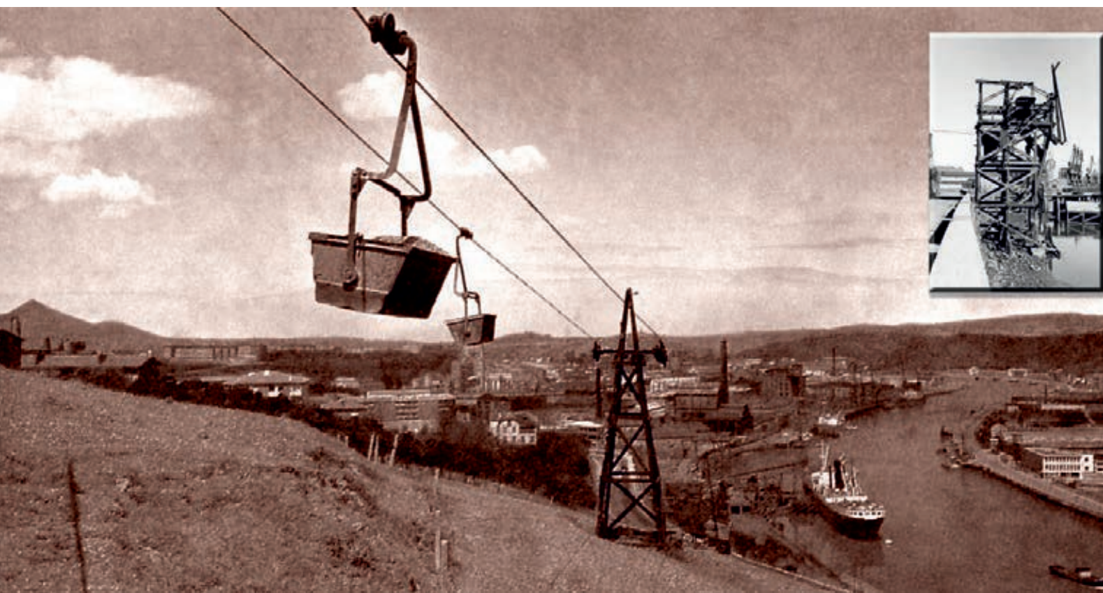
Figura 8. Llegada de la línea del tranvía aéreo a Zorroza, observándose al final de la línea los cargaderos de mineral (el de 1881 y el de finales de los años 50 del siglo XX) (colección particular Carmelo Uriarte). En la parte superior derecha, detalle del cargadero de 1881 (Cárcamo et al., 1987). Imagen facilitada por EHMM/MMPV.
