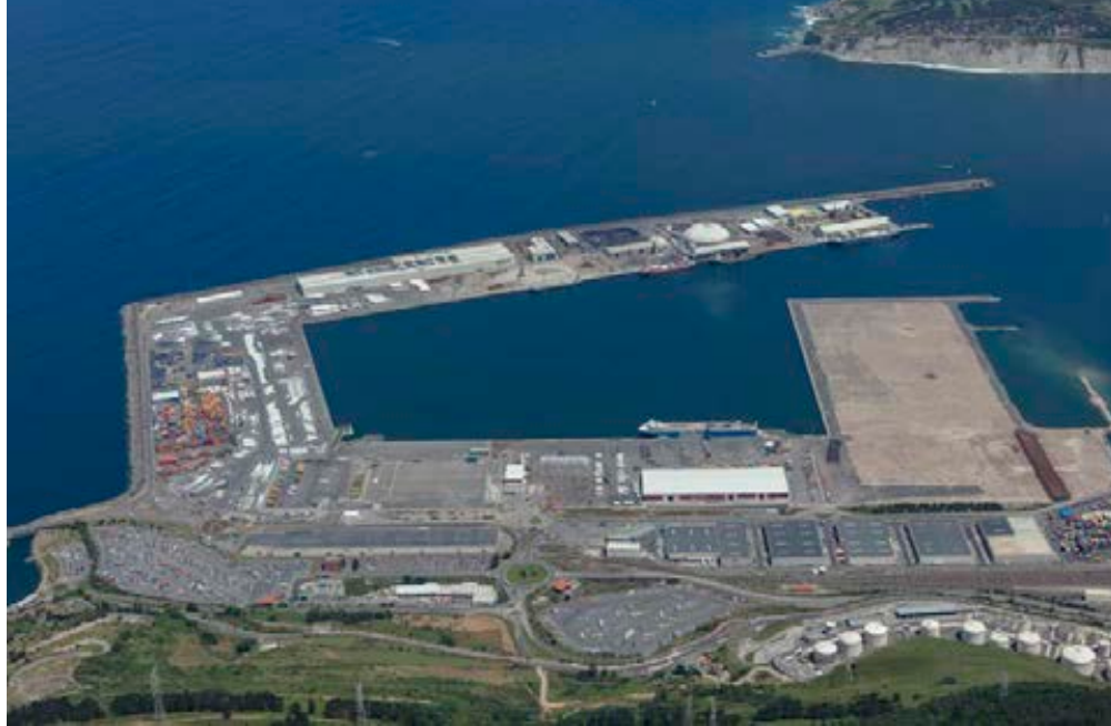
Muelles de la ampliación y primera fase del Espigón central (2020).
