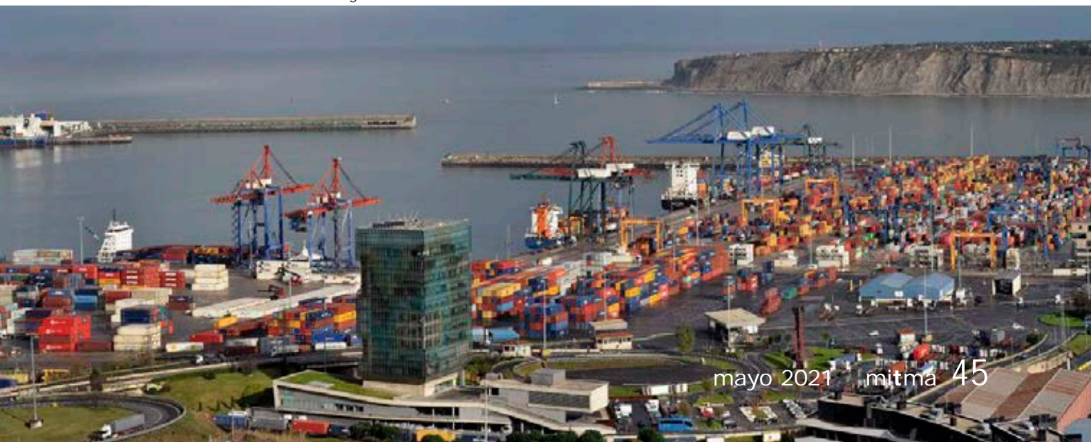
Terminal de contenedores en terrenos ganados al mar.
