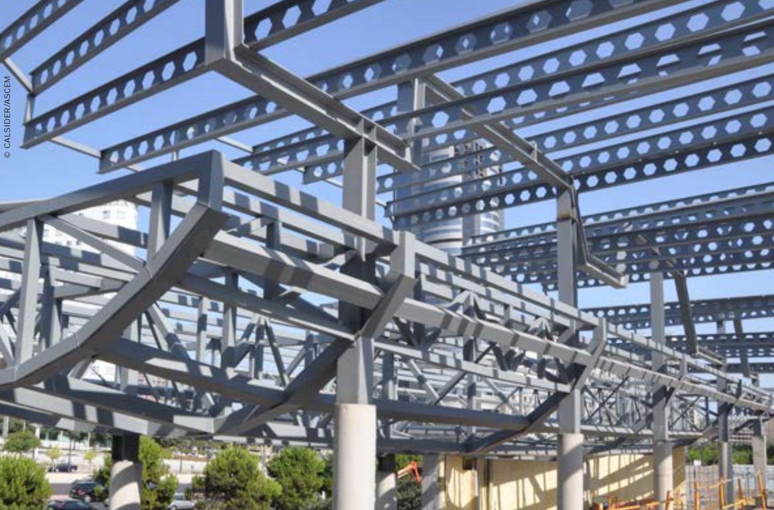
Estructura de acero (CALSIDER/ASCEM).
