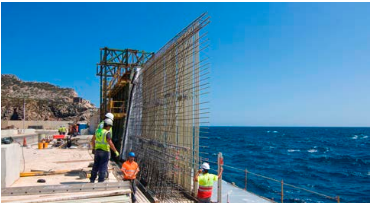
Colocación de la armadura.
