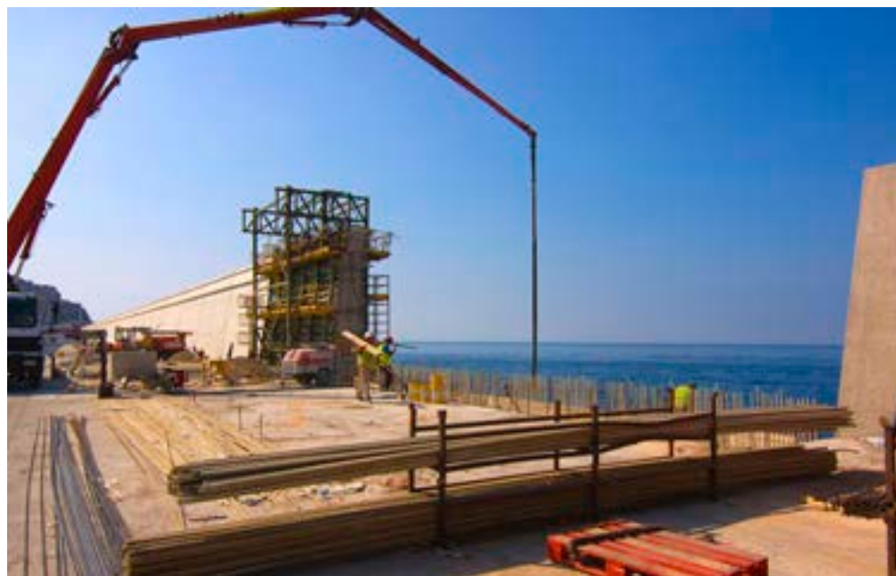
Hormigonado de la zona de apoyo.
