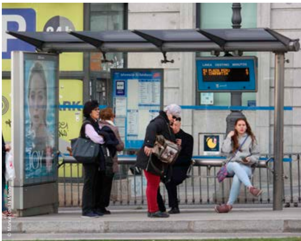
Marquesina de autobús en Madrid con panel informativo de los tiempos de llegada.
