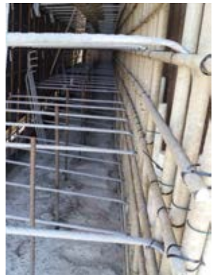
Armado interno del espaldón (finalizado).
