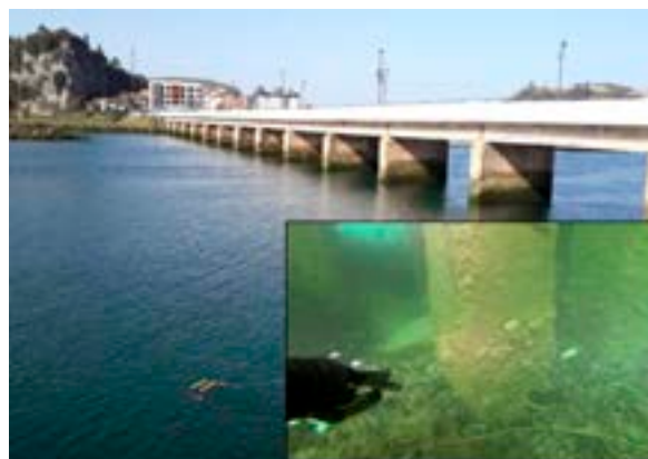
Reparación y ampliación de la estructura sobre el río Sella en la N-632.
