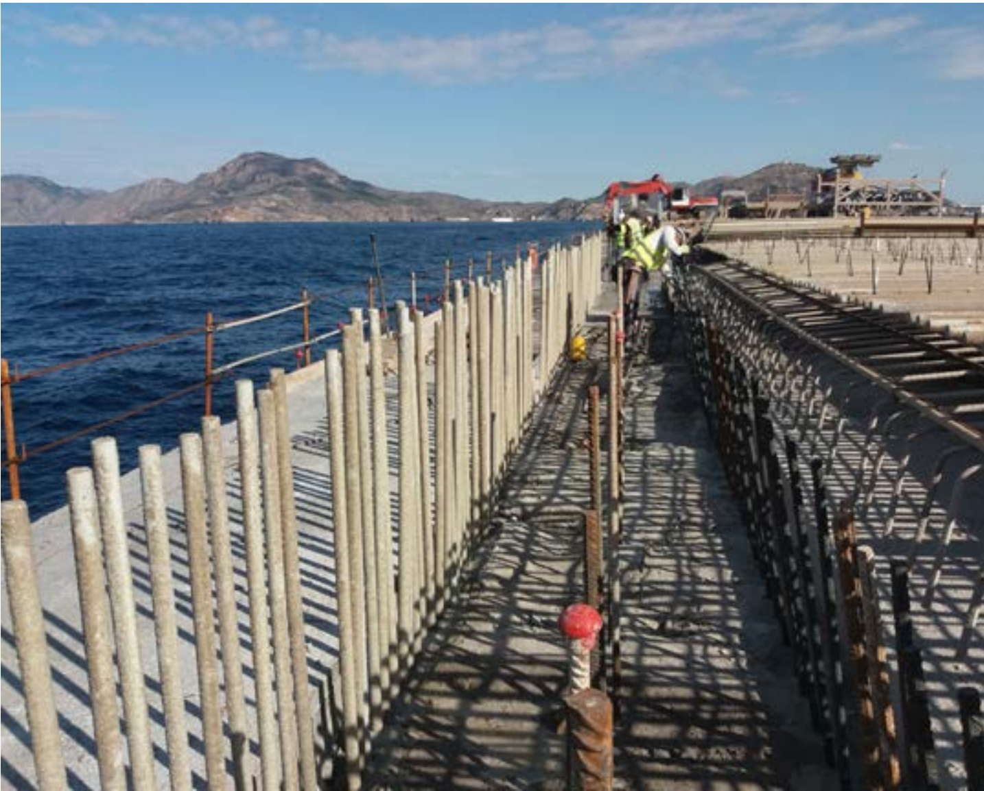
Esperas de conexión de PRFV y Acero.
