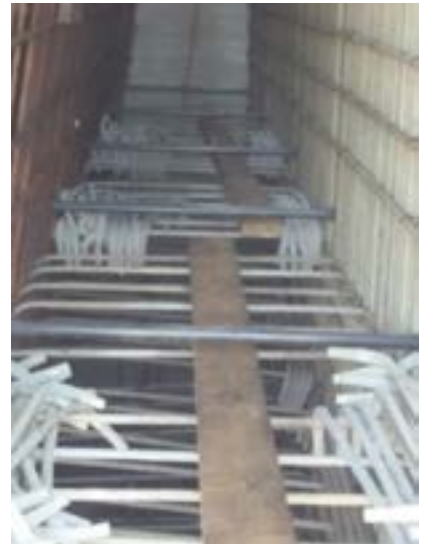
Armado interno del espaldón (en ejecución).
