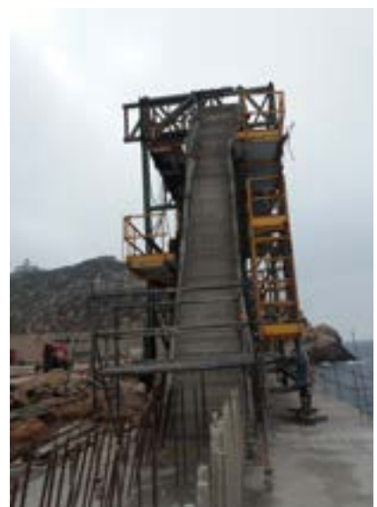
Desencofrado de una puesta.
