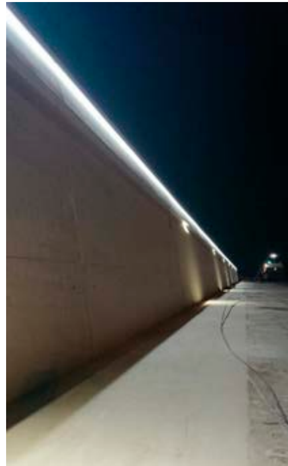
Espaldón finalizado con iluminación.
