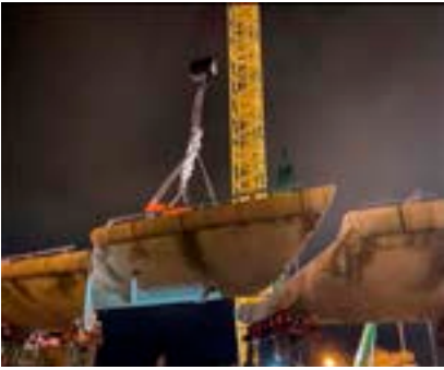
Demolición de una estructura de hormigón.
