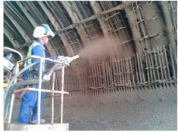
Puesta en obra de hormigón proyectado.
