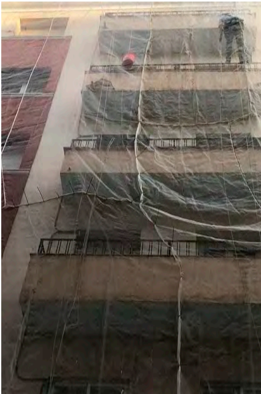
Edificio de viviendas en rehabilitación de la fachada.
