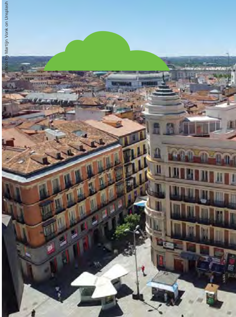
Actuaciones en la rehabilitación de barrios.
