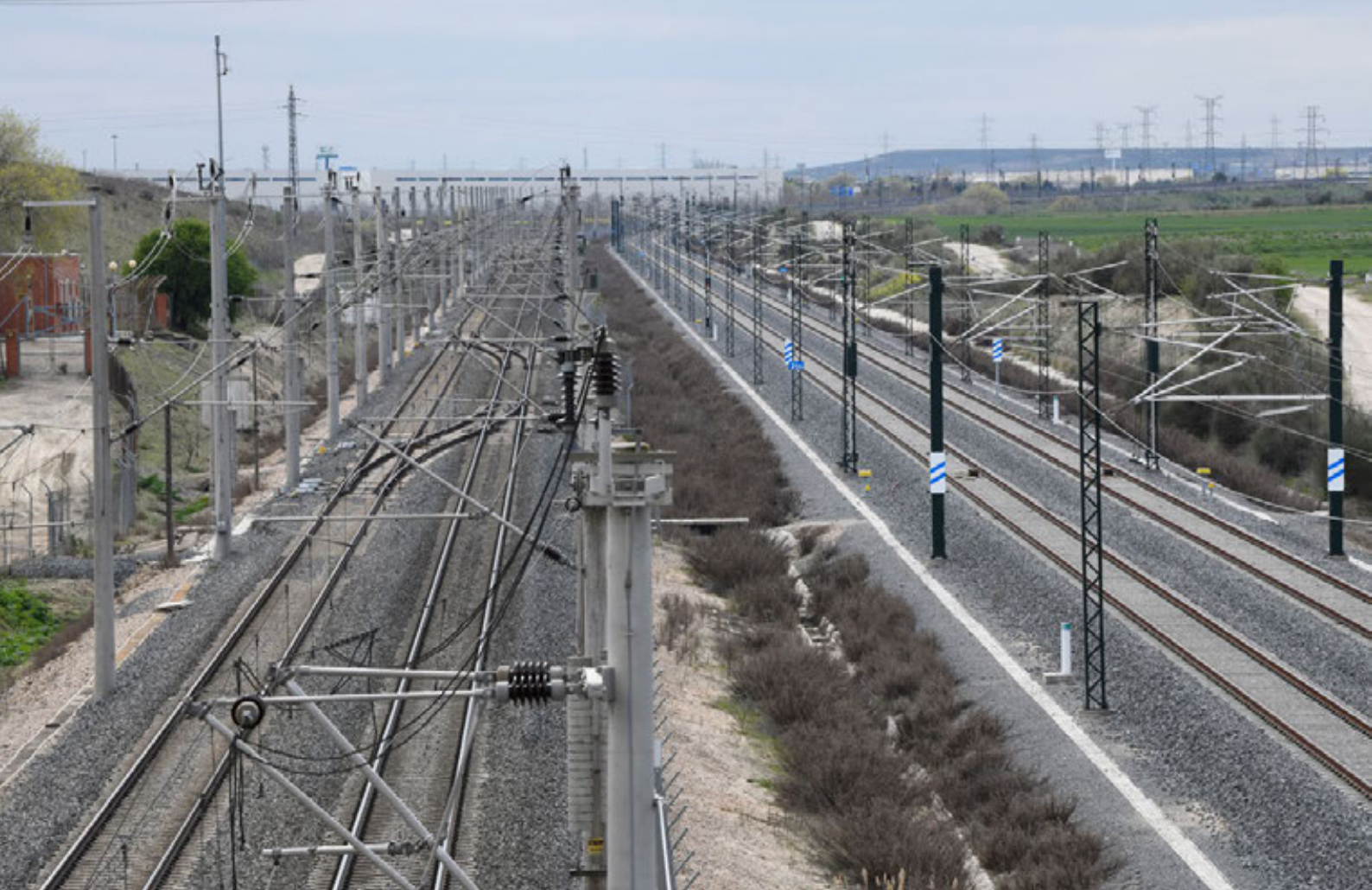
A la izquierda la LAV Madrid-Sevilla, a la derecha las dos nuevas vías del acceso sur.
