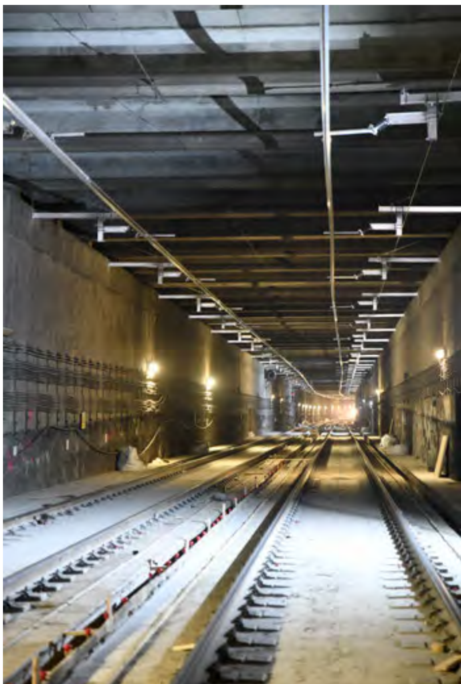
Túnel de Getafe.
