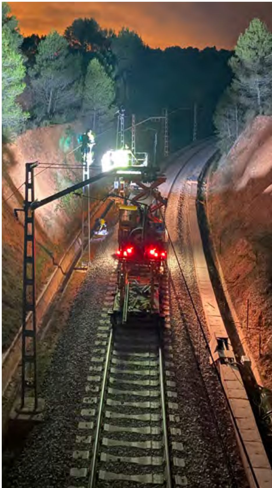
Trabajos nocturnos en el tramo Castellbisbal-Martorell.
