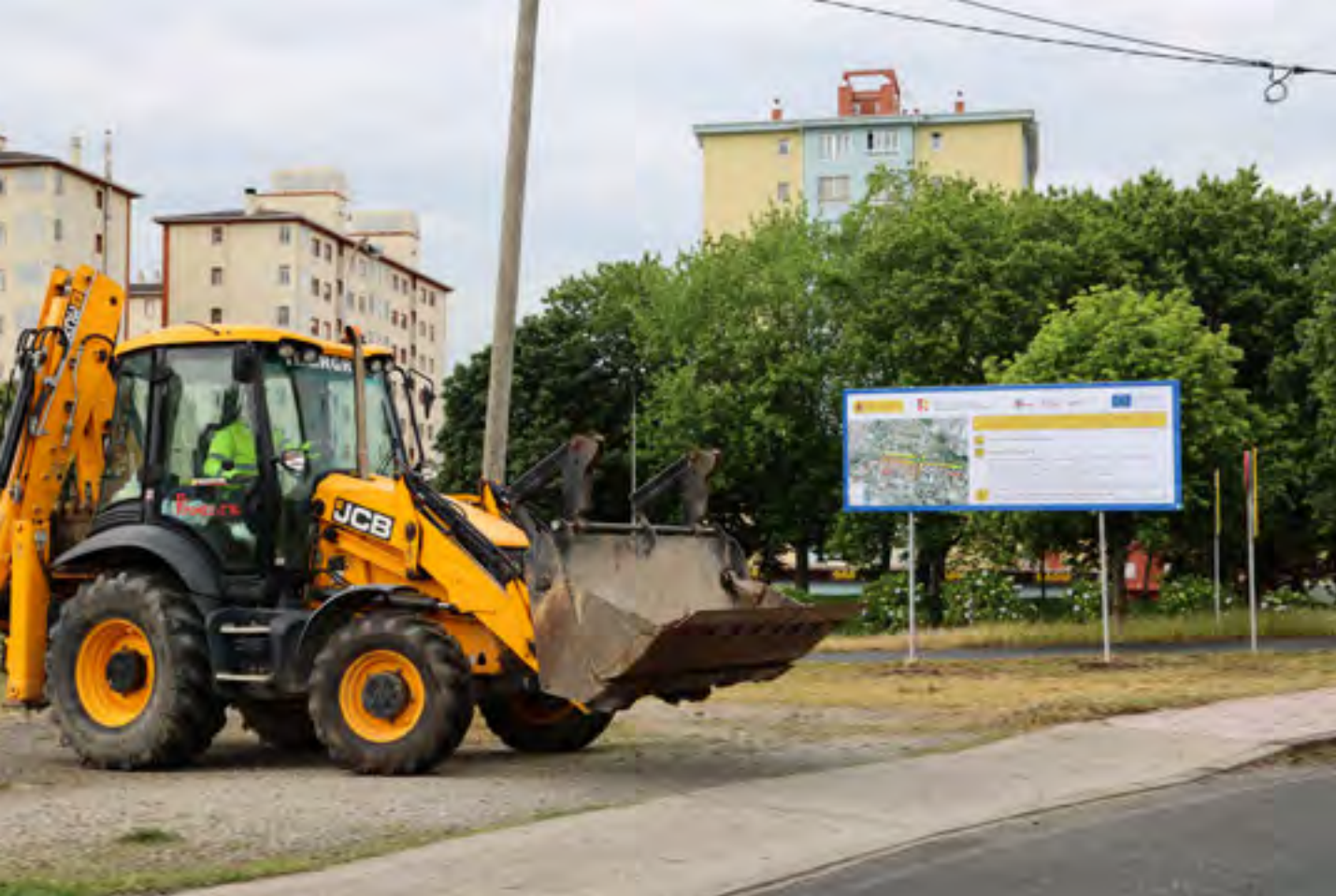
Las obras de humanización de la Avenida As Pías (Ferrol) ya han comenzado.
