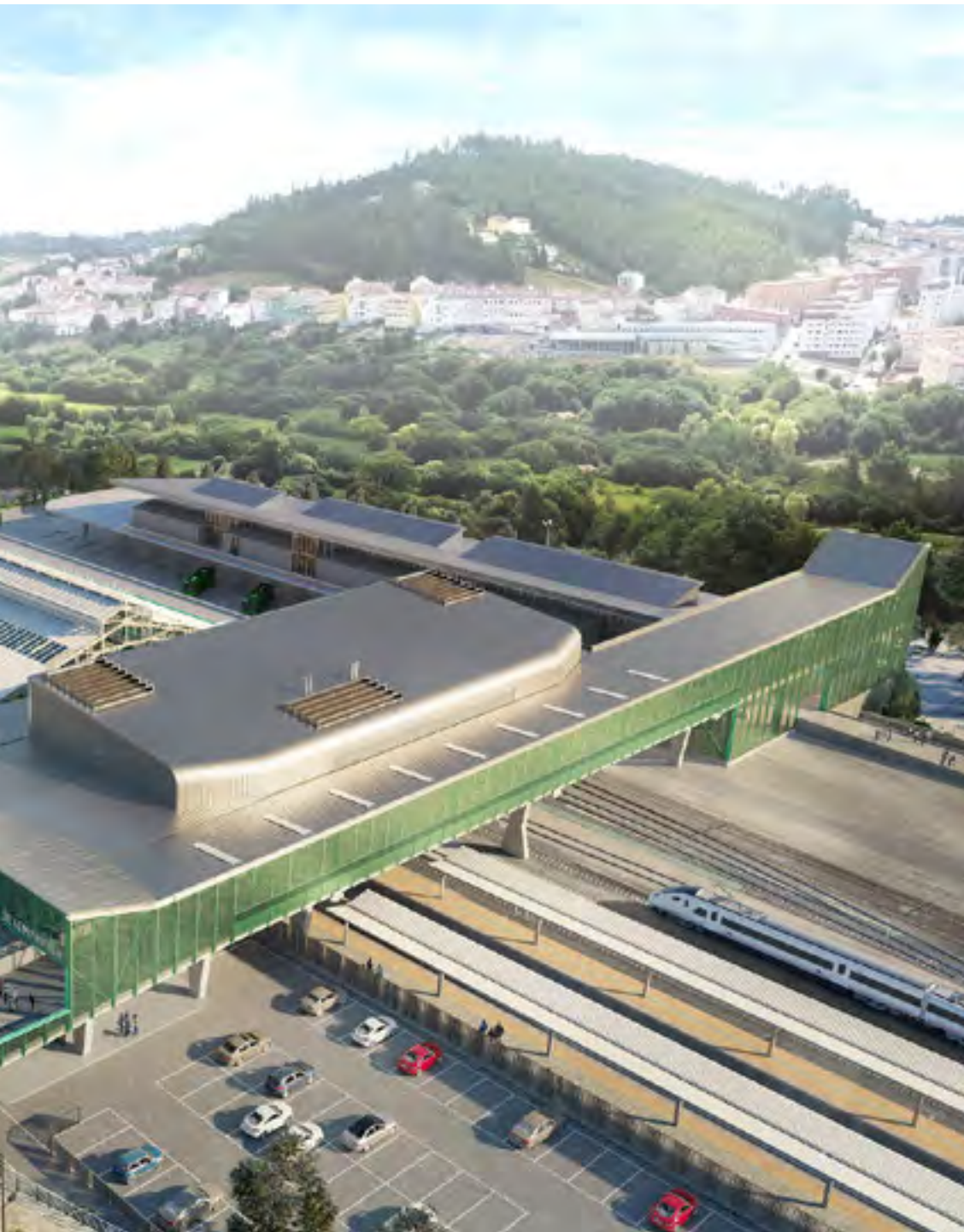
El nuevo edificio de viajeros de la estación de Santiago (situada en una de las secciones del Corredor Atlántico) está financiado por los fondos MRR.
