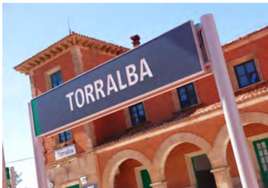
A la izquierda estación de Soria y encima de estas líneas estación de Torralba.
