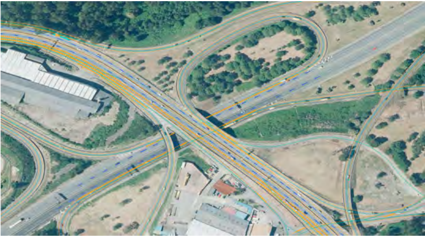
Detección de elementos de delineación de las carreteras con IA sobre las marcas viales horizontales.
