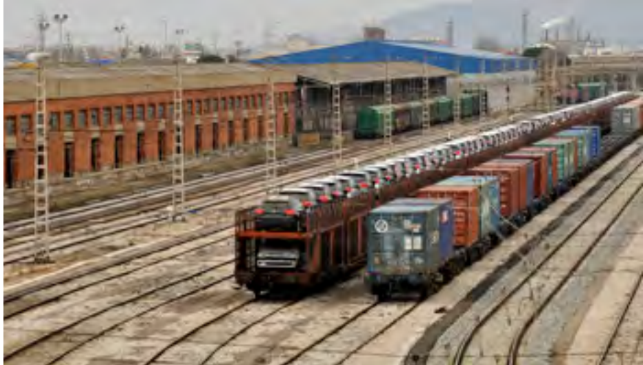
Vista de la terminal de Can Tunis (Barcelona).
