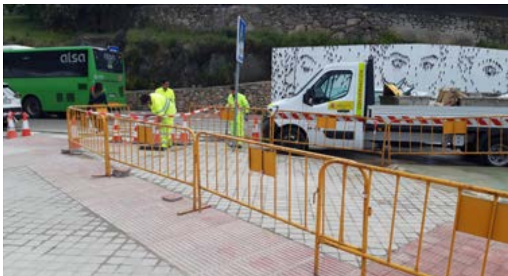
Trabajos de mejora del pavimento peatonal.
