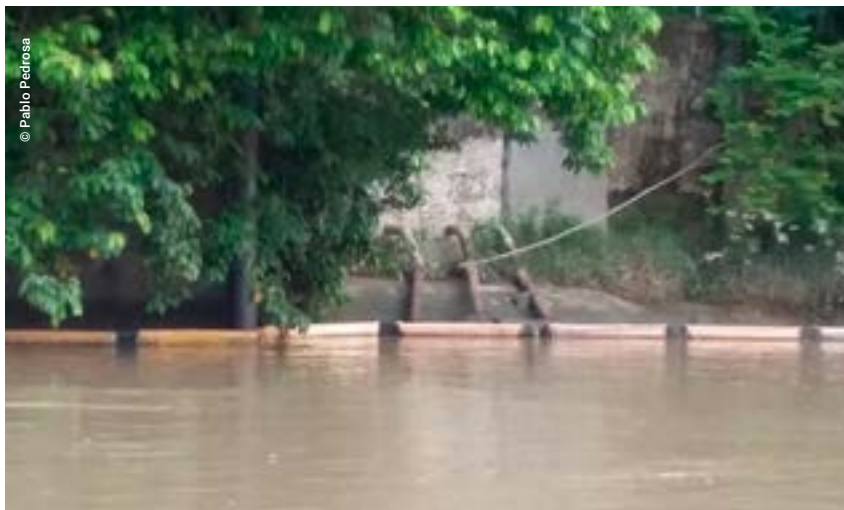
Protección de tomas agua en el Rio Sogamoso, como infraestructura crítica después del incidente del Pozo Lisama en Colombia .2018.
