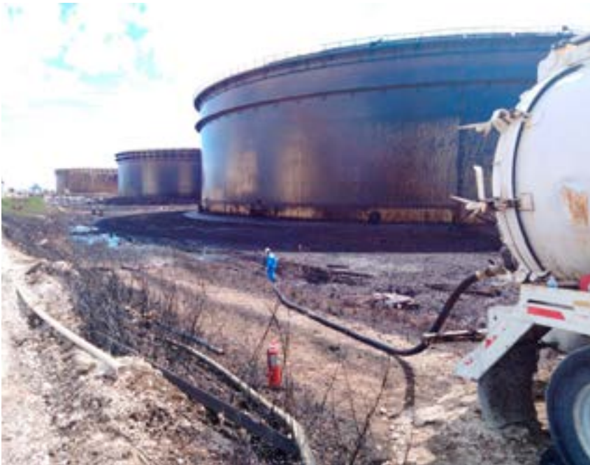
Estudio de campo después de los efectos provocados por el huracán Dorian.
