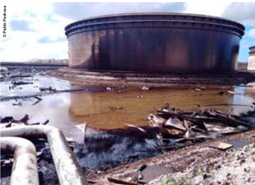
Efectos del huracán Dorien en Bahamas sobre instalación de almacenaje de hidrocarburos.
