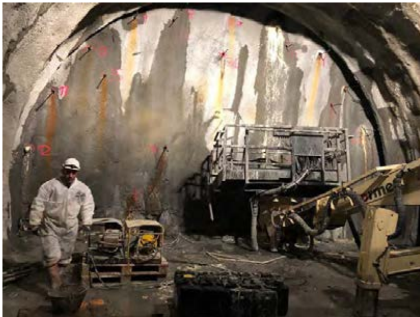
Inyecciones de resina en el túnel de Brión.
