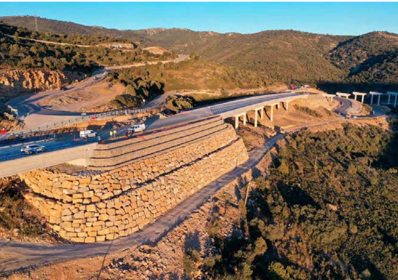
Muro de escollera ejecutado entre dos viaductos.
