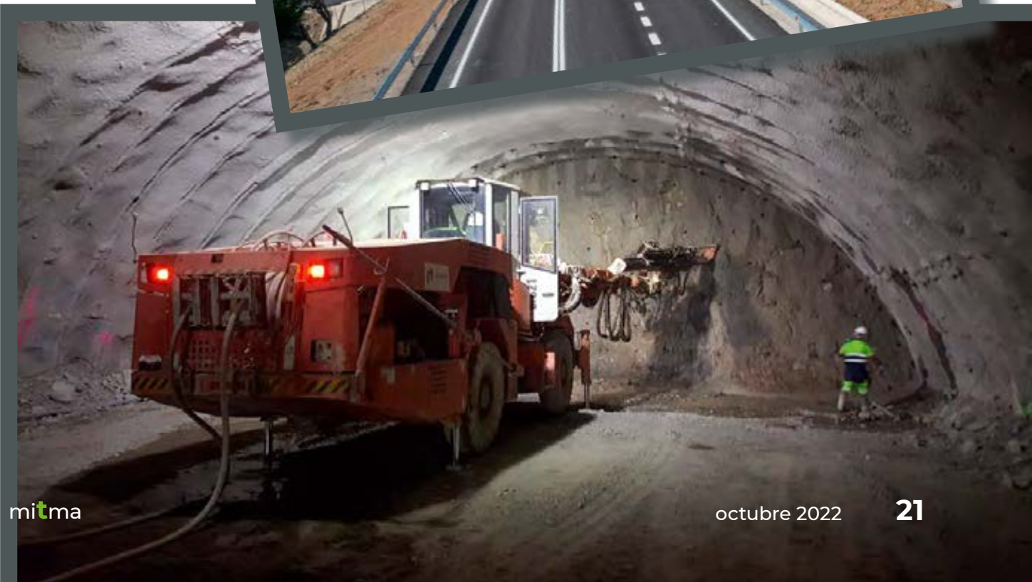
Jumbo de perforación en acción en el túnel de Querol.
