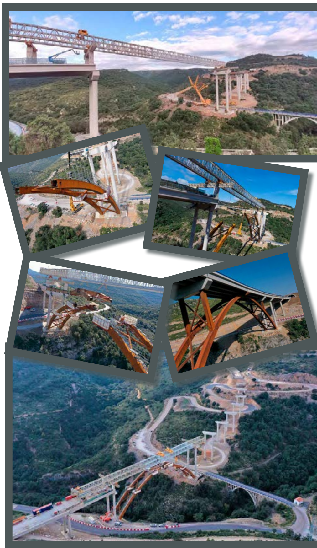
Secuencia del montaje del arco del viaducto del barranco de la Bota.
