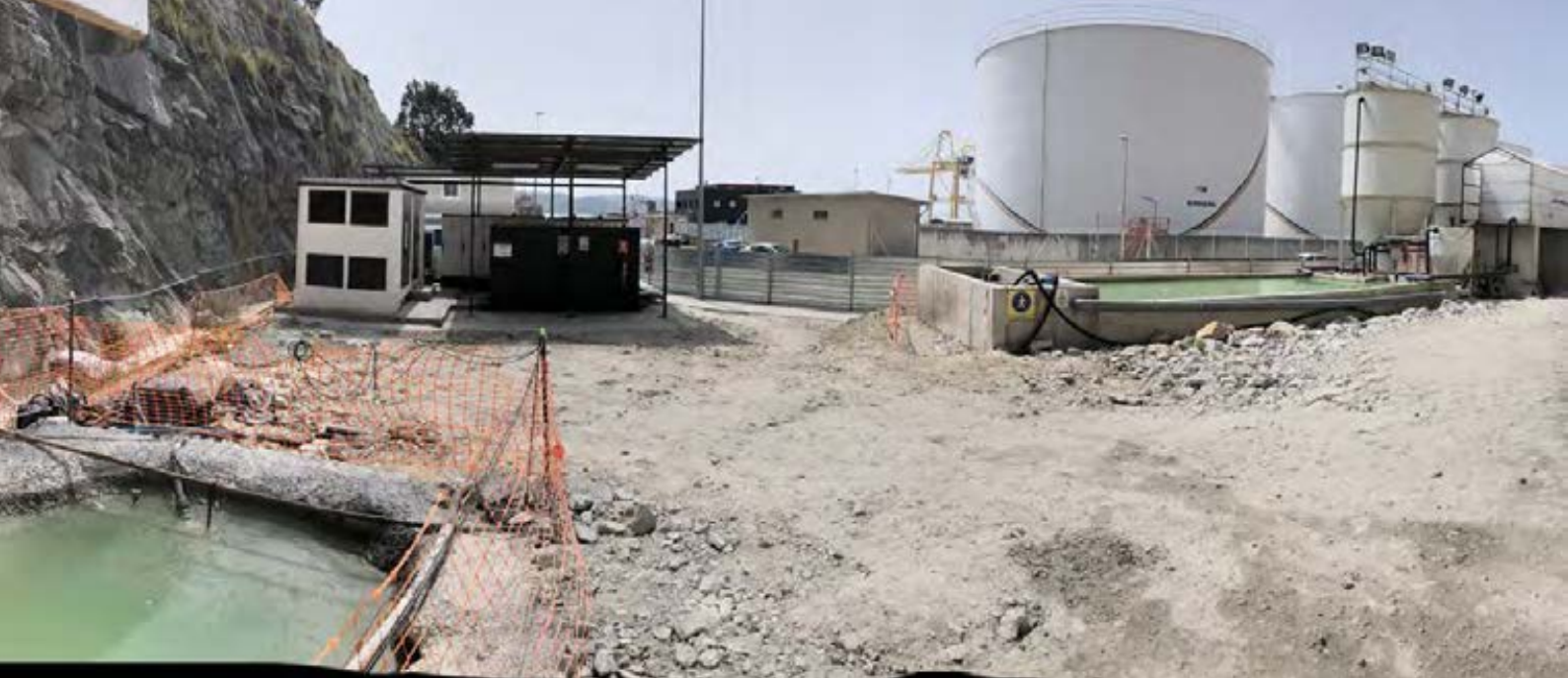
Instalaciones asociadas al túnel en el emboquille oeste (Puerto Exterior).
