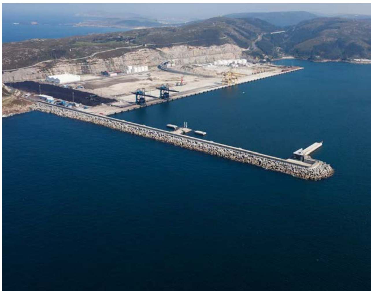
Puerto Exterior de Ferrol.
