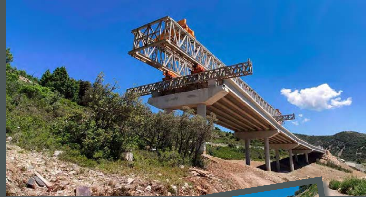
Equipo lanzador de vigas empleado en la ejecución de los viaductos.
