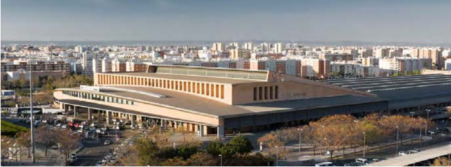
Uno de los principales proyectos del plan se ejecutará en la cubierta de la estación Sevilla Santa Justa.
