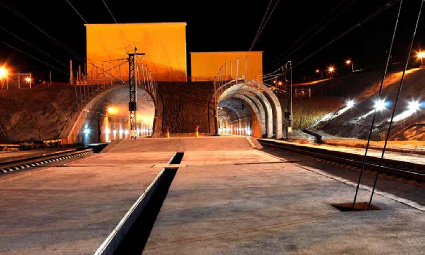
La única planta solar del plan de autoconsumo se ubicará en terrenos junto a la boca sur del túnel de Guadarrama.
