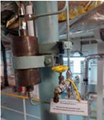
Toma de muestra de combustible a bordo.
