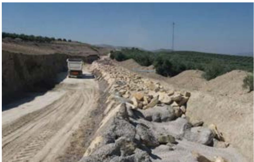
Tratamiento de terraplén.
