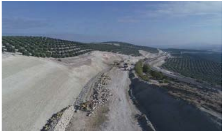
Tratamiento de escollera en desmante.
