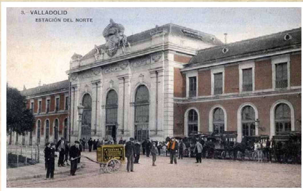
Tarjeta postal de la estación del Norte de Valladolid a principios del siglo XX. Las estaciones de ferrocarril se convirtieron en uno de los elementos impulsores más destacados del proceso de urbanización que conocieron las ciudades españolas.
