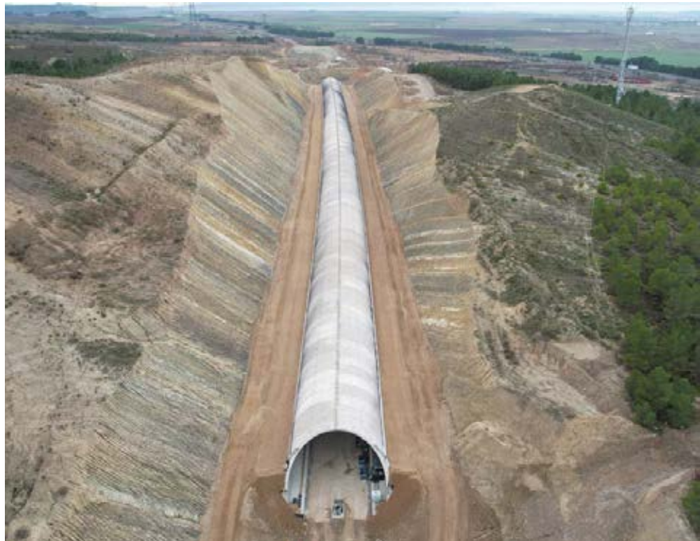
Falso túnel de El Montico, en el tramo Villafranca-Peralta.
