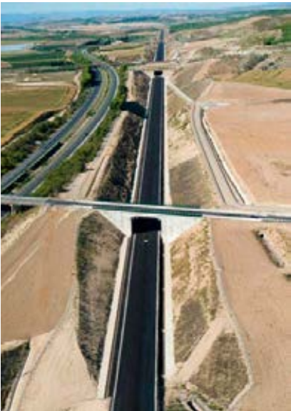
Plataforma terminada del tramo Castejón-Cadreíta.
