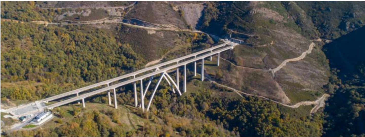
El viaducto de Teixeiras adaptó su diseño y construcción para minimizar la afección a un LIC.
