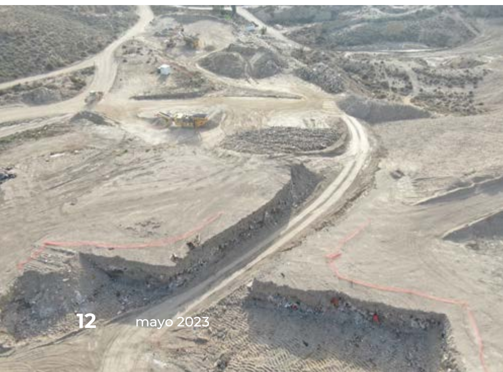
Vista aérea del tratamiento de un vertedero situado en la LAV Murcia-Almería.
