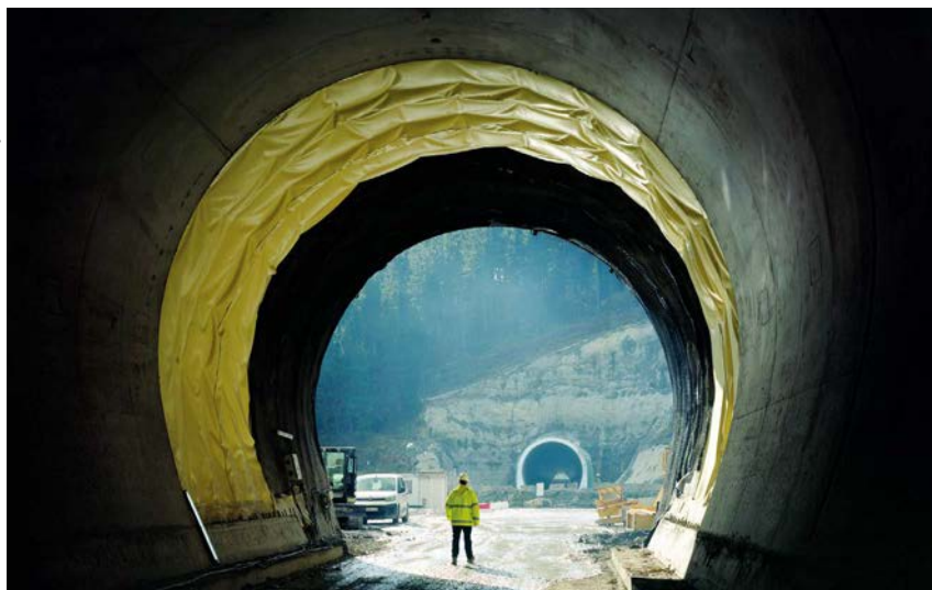
Túnel de Karraskain visto desde el túnel de Udalaiz.
