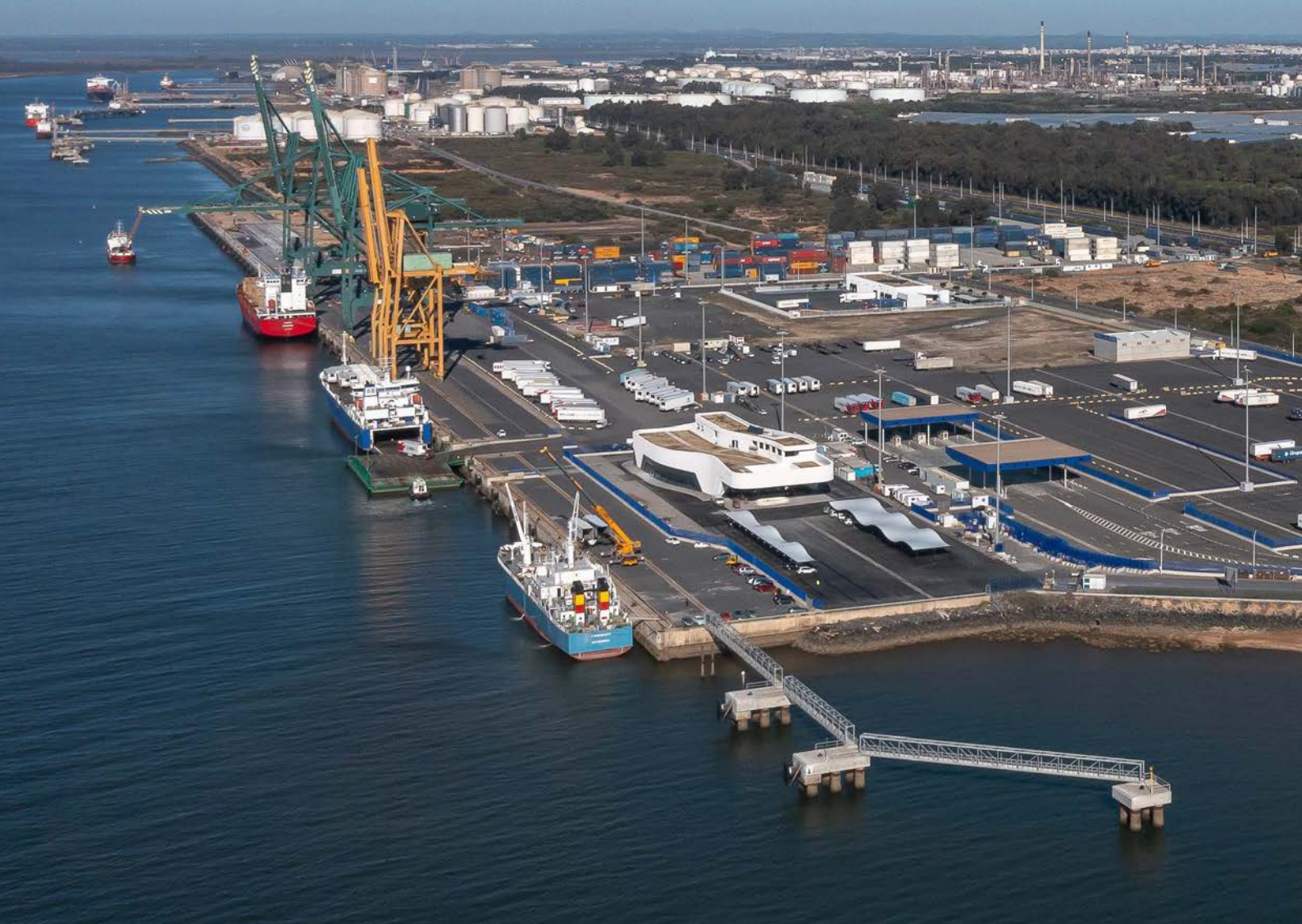
Muelle sur del Puerto de Huelva.
