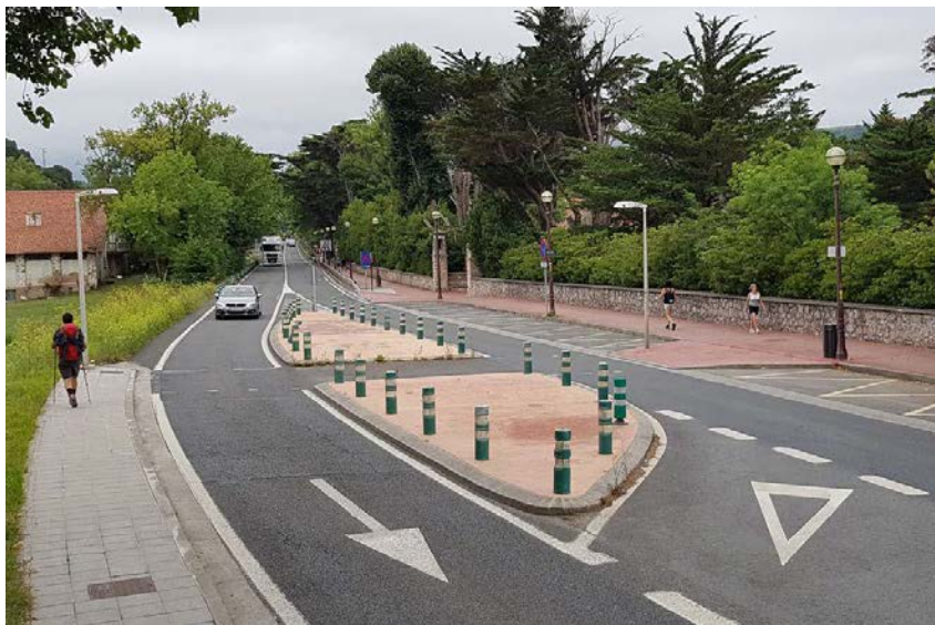
Cruce peatonal /ciclista sin prioridad sobre carretera.
