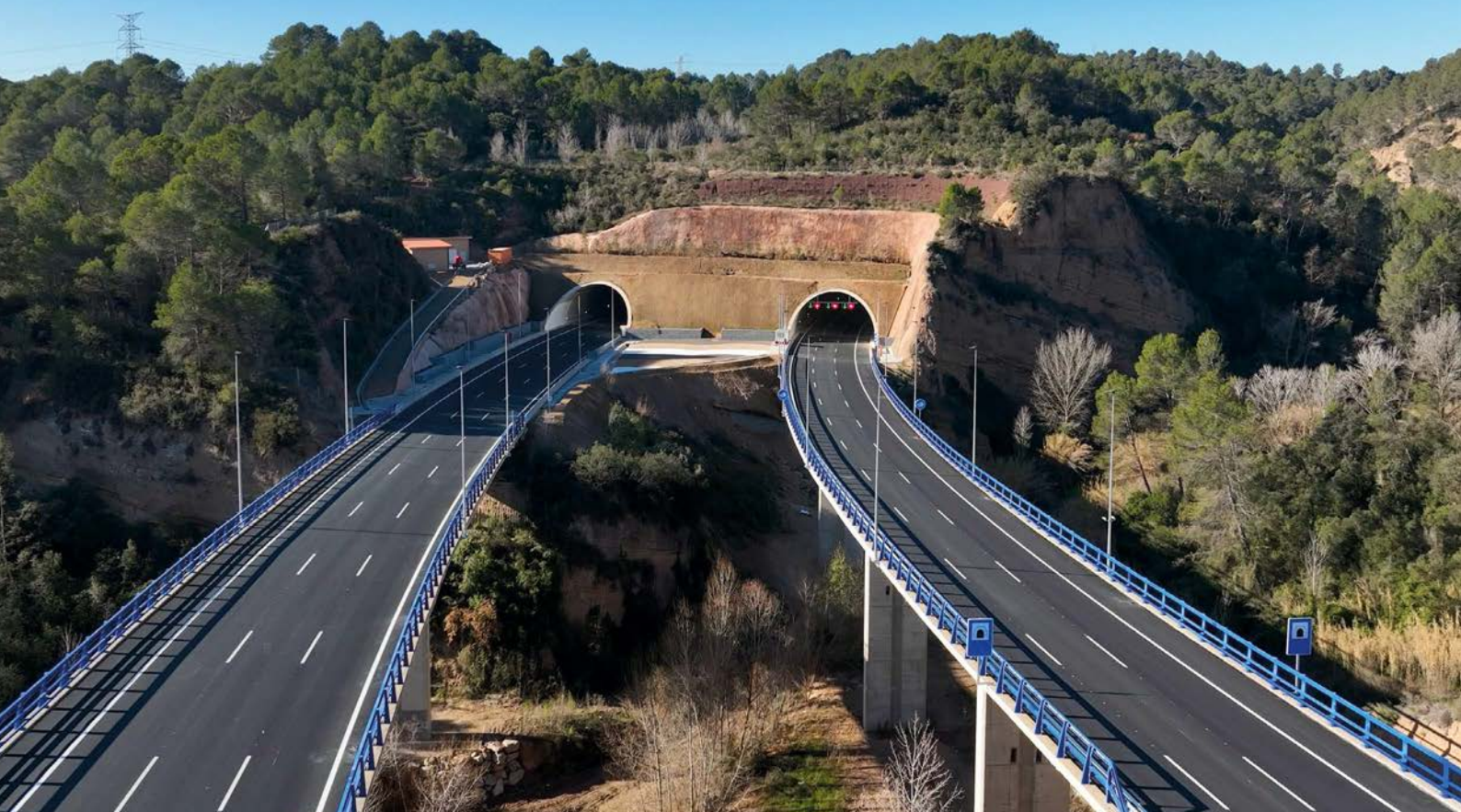
Boca este del túnel de Voltrera y viaducto sobre la riera de Sant Jaume.
