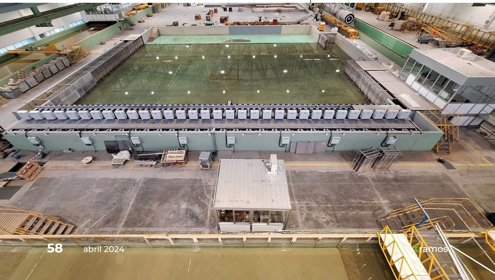
Tanque de oleaje multidireccional.
