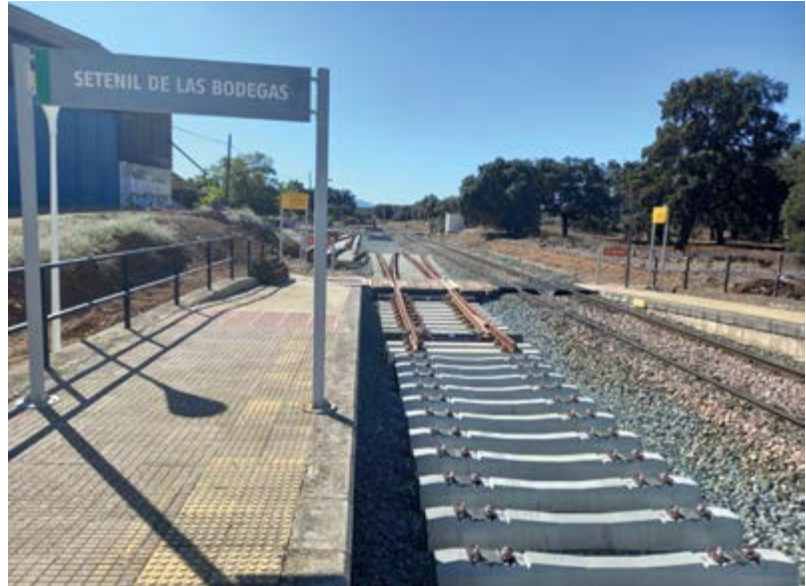
Vía de apartadero en Setenil de las Bodegas.
