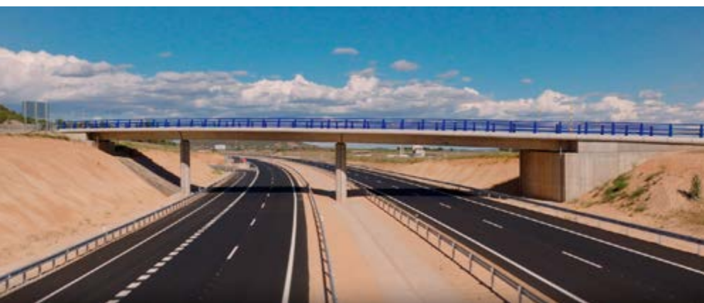
Paso superior del enlace de San Esteban de Gormaz.
