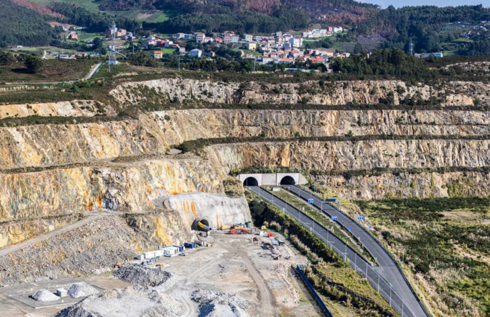
Vista aérea de la boca del túnel ferroviario 2 de acceso al puerto exterior, en ejecución, y del túnel bitubo de carretera, ya en servicio.
