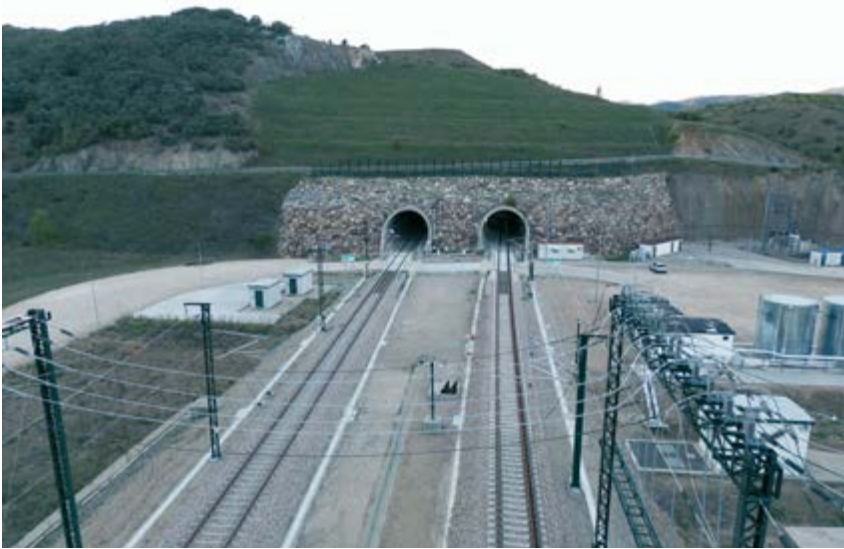
Boca sur del túnel de Pajares.
