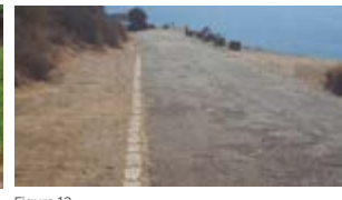
Figura 12 Carretera: Transferida indeterminada (N-340) Provincia: Málaga Coordenadas: X: -3,816 Y: 36,752 Tipología: Encintado lateral. Circuito Nacional de Firmes Especiales (1926/1939).
