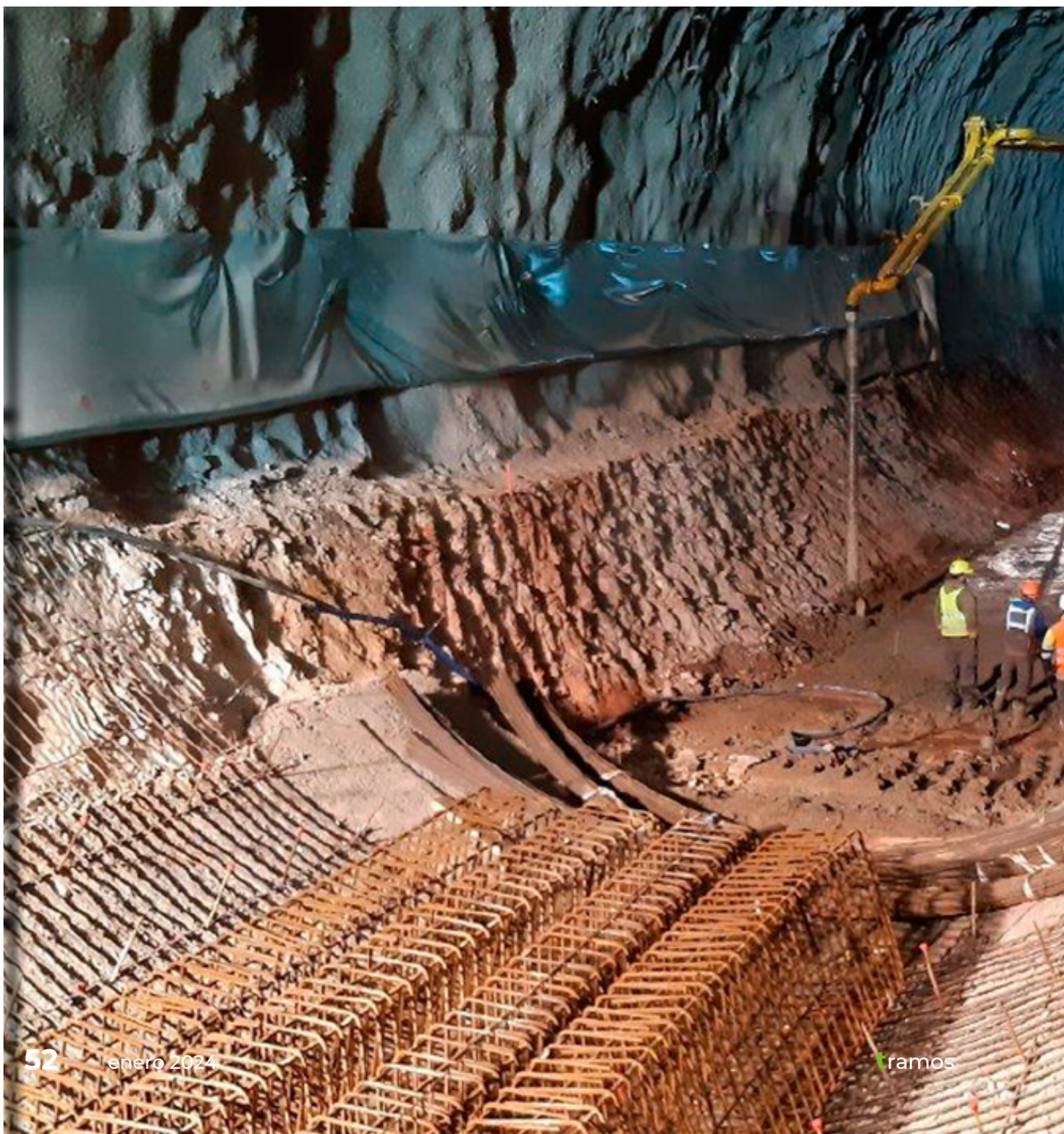
Ejecución de contrabóveda de hormigón armado en lutitas con yeso y anhidritas.
