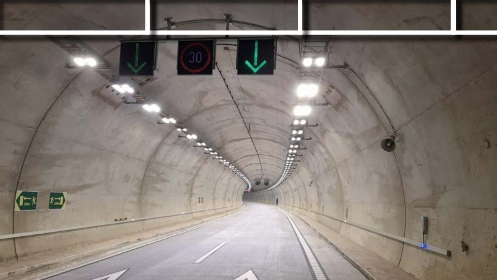
Vista del interior del túnel (sobre estas líneas) y de una de las bocas (página derecha).
