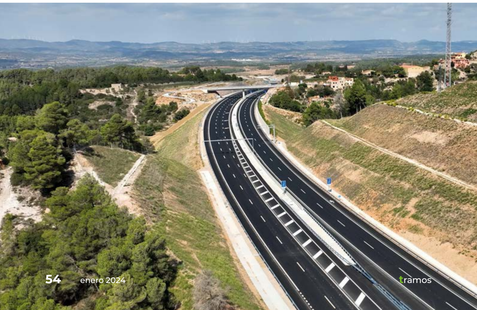
Panorámica del desmonte en el p.k. 3-800.
