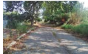
Figura 9 Carretera: A-38 (N-332) Provincia: Valencia Coordenadas: X: -0,202 Y: 39,008 Tipología: Adoquinado con bordillo en travesía. Circuito Nacional de Firmes Especiales (1926/1939).
