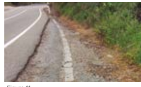
Figura 11 Carretera: N-630 Provincia: Sevilla Coordenadas: X: -6,184 Y: 37,676 Tipología: Encintado lateral y firme de macadam con riegos. Circuito Nacional de Firmes Especiales (1926/1939).
