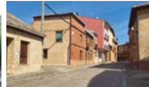
Figura 10 Carretera: Travesía transferida (N-610) Provincia: Valladolid Coordenadas: X: -5,033 Y: 42,098 Tipología: Adoquinado con encintado en travesía. Circuito Nacional de Firmes Especiales (1926/1939).
