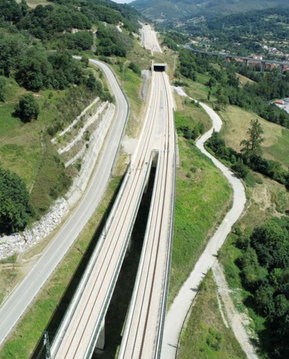
Viaducto doble de Teso y, al fondo, PAET de Campomanes (Asturias).
