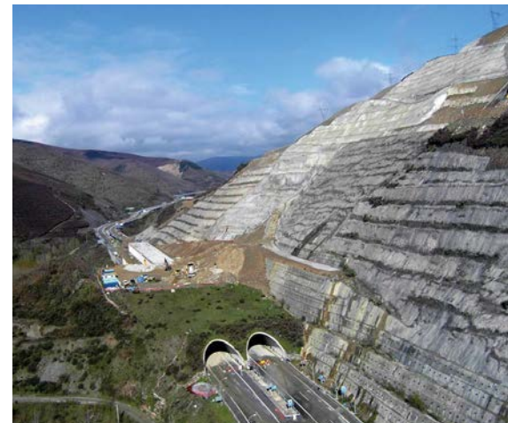
Vista del talud de Trabadelo.
