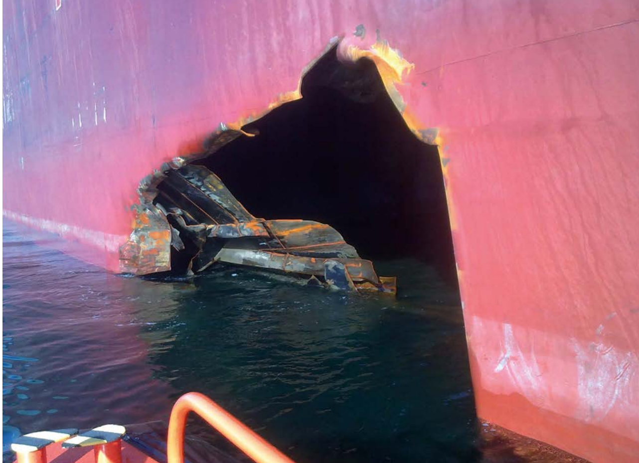
Buque accidentado con daños estructurales.
