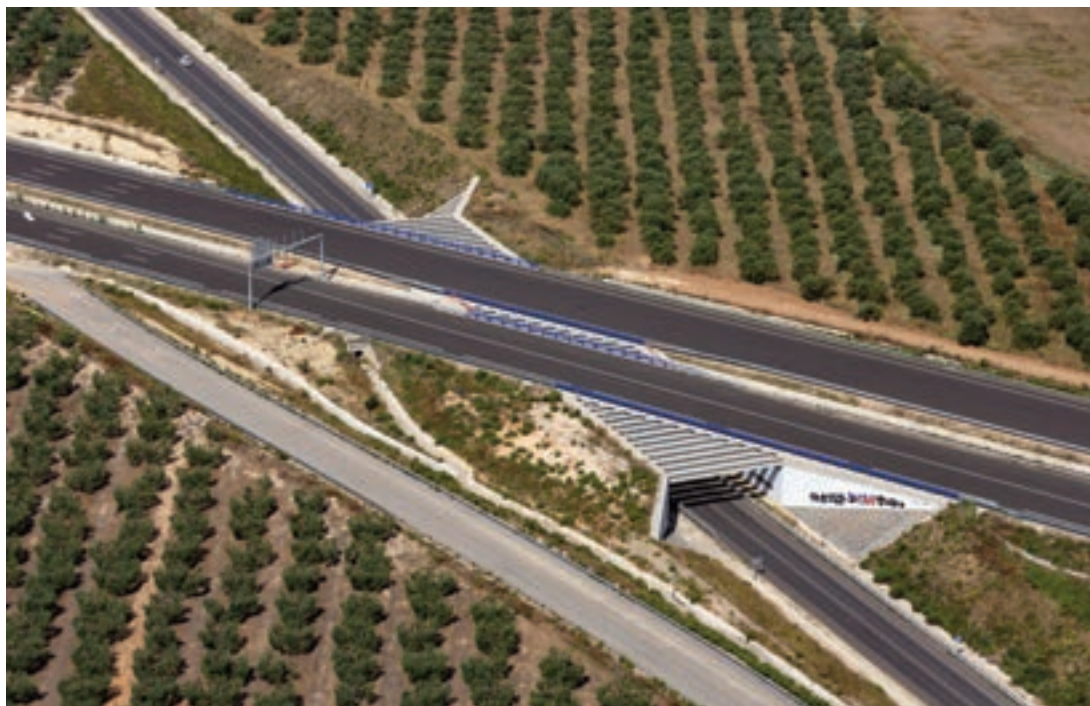
► Paso inferior de la carretera A-474 que fue deprimida para realizar el cruce con la SE-40 a distinto nivel.
