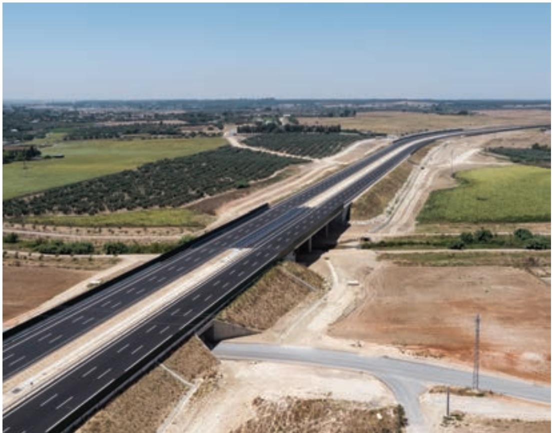
► Viaducto sobre el arroyo del Repudio y paso inferior para reposición de camino en el tramo Coria del Río-Almenseilla.
