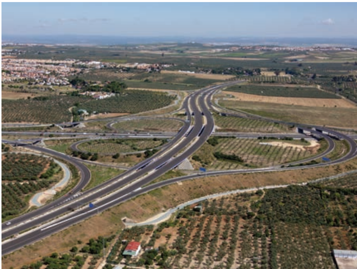
► Enlace con la autovía A-49, principal elemento del tramo Almensilla-Espartinas.
