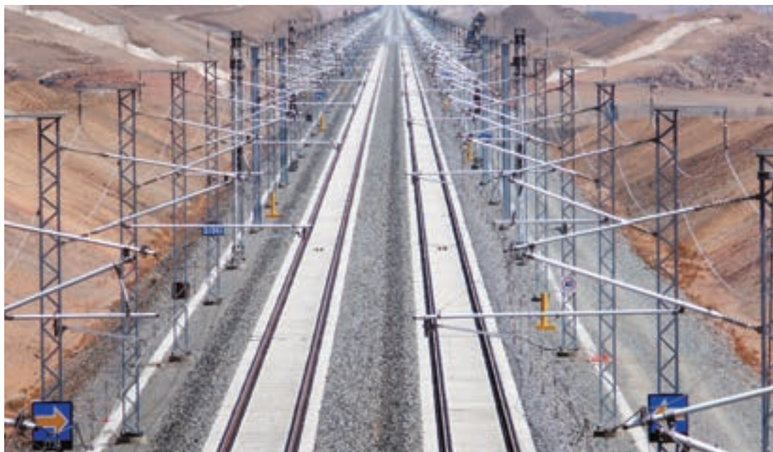
► Tramo en el pk 273 del área 4 del trazado, entre las estaciones de KAEC y Medina
