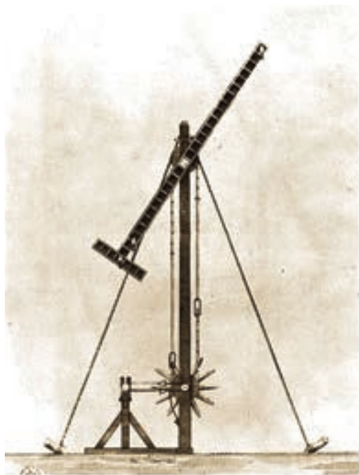
► Telégrafo óptico de Betancourt y Abraham Louis Breguet (catálogo de la exposición Betancourt, los inicios de la ingeniería moderna, Cehopu, 1996).
