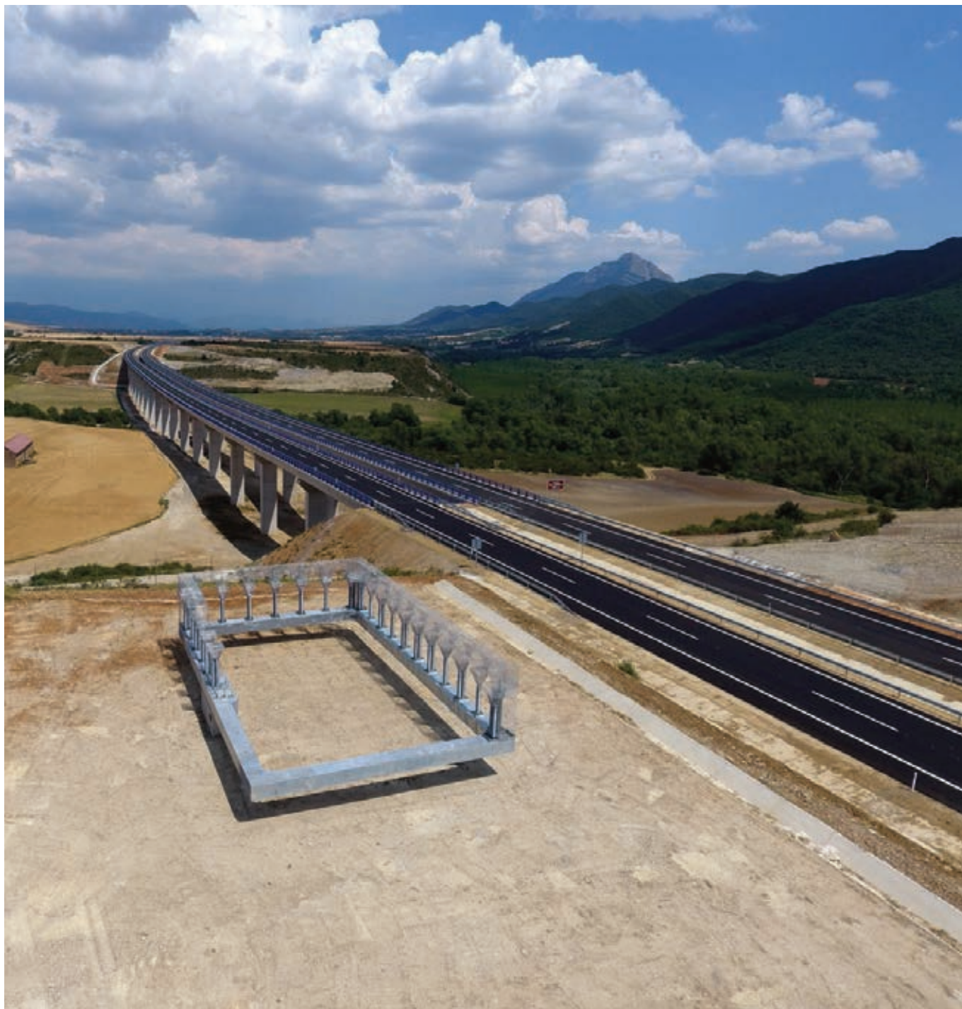
► Viaducto de Lubierre (816 metros), el de mayor longitud del trazado
