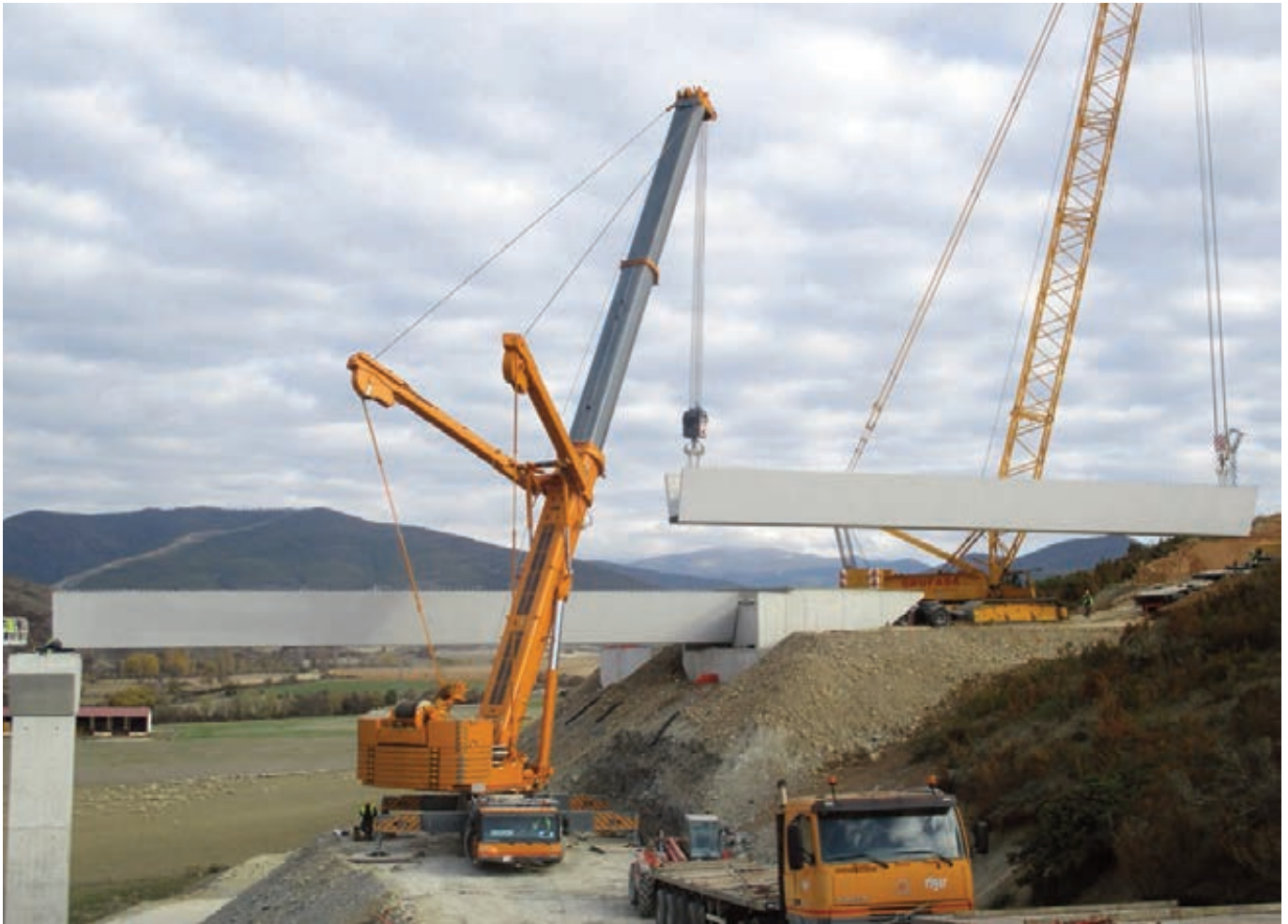
► Izado para el montaje de viga artesa en uno de los viaductos del tramo.
