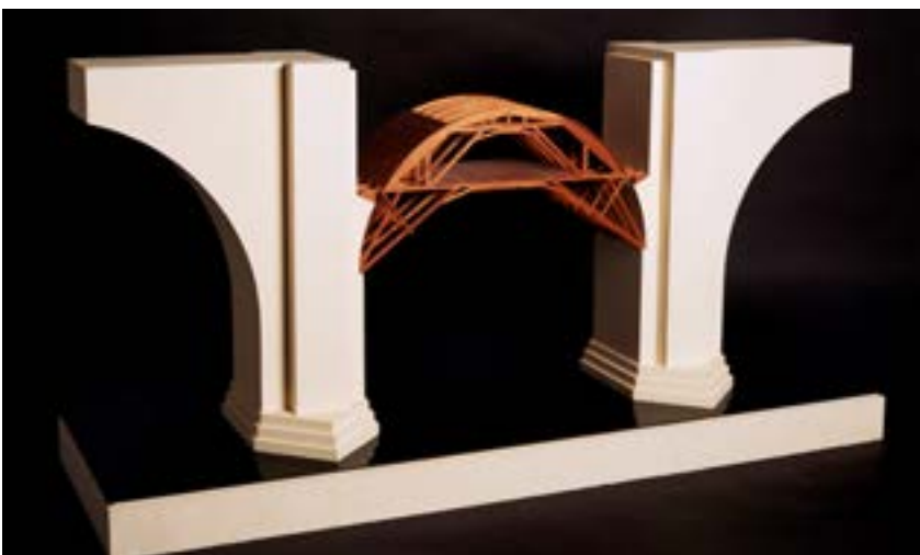
Cimbra para la reconstrucción del puente romano de Alcántara.
