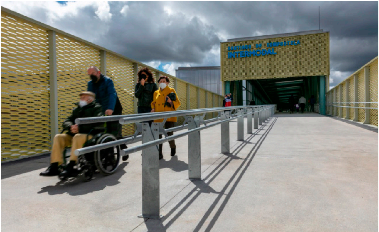
Acceso mediante rampas a las nuevas instalaciones.
