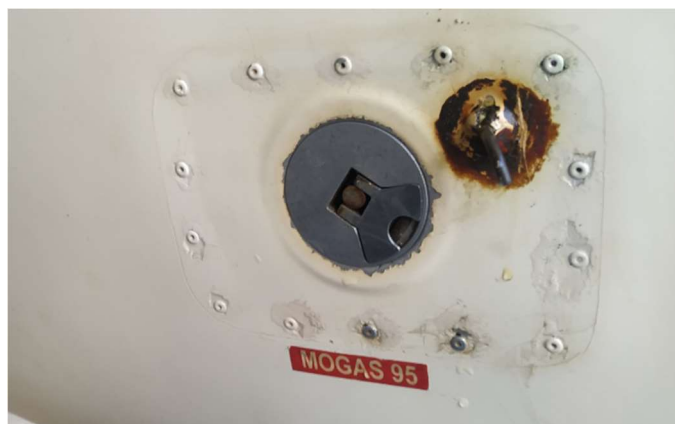
Ilustración 10 Placa de acceso al depósito de combustible
