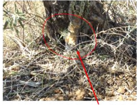
Daño en el tronco del olivo
