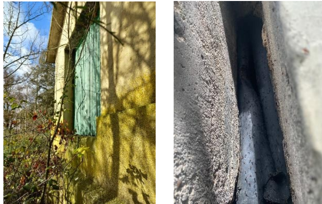
Ilustración 2: Caseta desde la que partía el extremo más septentrional del cable
