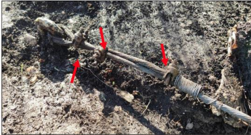
Ilustración 13: Detalle de los tres sujetacables en la fijación de la instalación aérea en la margen izquierda del río
