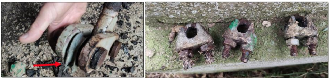
Ilustración 12: Detalle del tirante con el guardacable (a la izquierda) y los tres perrillos (a la derecha)
