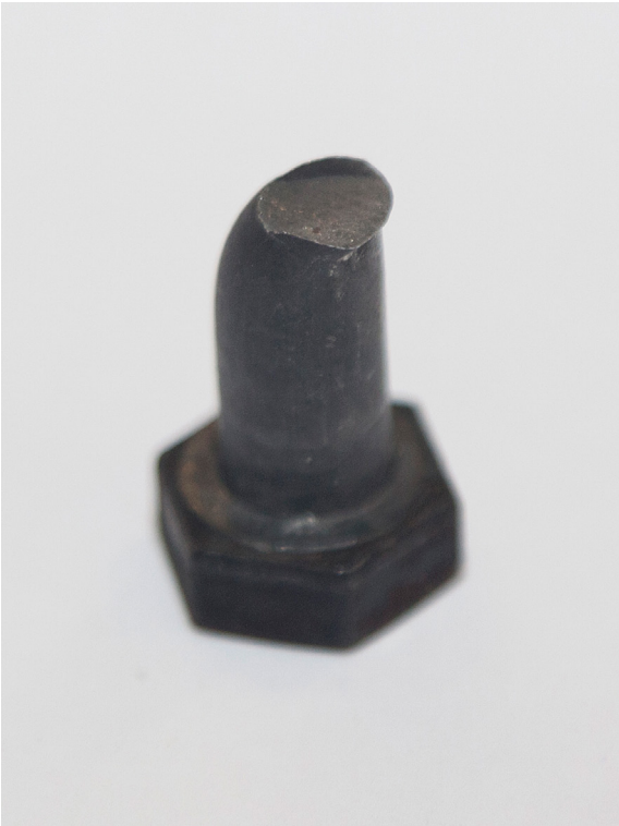
Figura 12:Detalle de la rotura del tornillo central del tren principal
