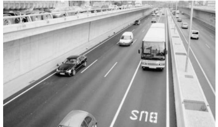
Carril bus sin barreras físicas en la C-31, Barcelona
