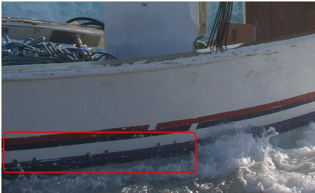
Fotos 3 y 4. Detalle de los orificios de desagüe de la cubierta
