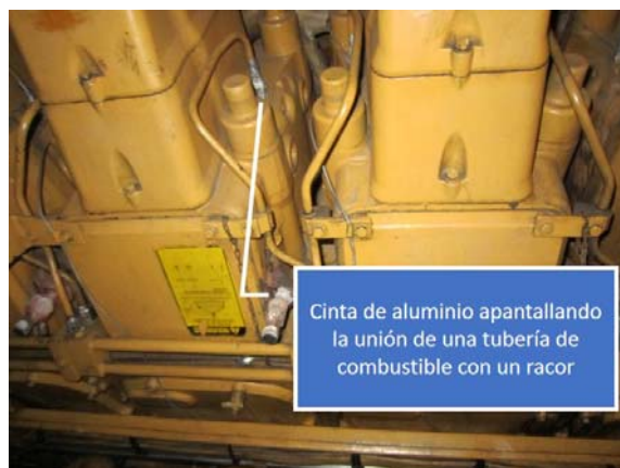
Figura 5. Ejemplo de uso de cinta de aluminio sobre una tubería de combustible a alta presión en su inserción sobre la culata de un motor
