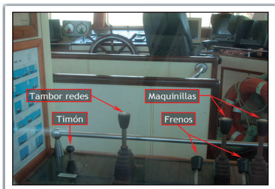
Figura 15. Accionamiento remoto en el puente, visto desde la popa
