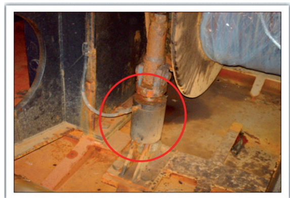
Figura 13. Sensor de fuerza para la medida de la tensión en la maquinilla de arrastre
