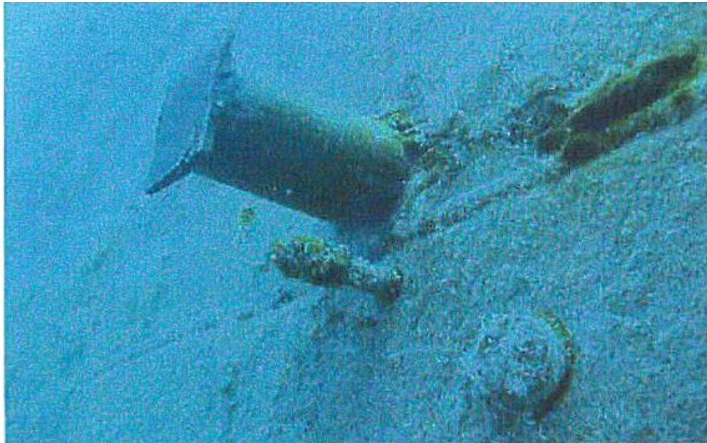
Foto 13: Cierre de acero sobre espiche en los tanques de doble fondo
