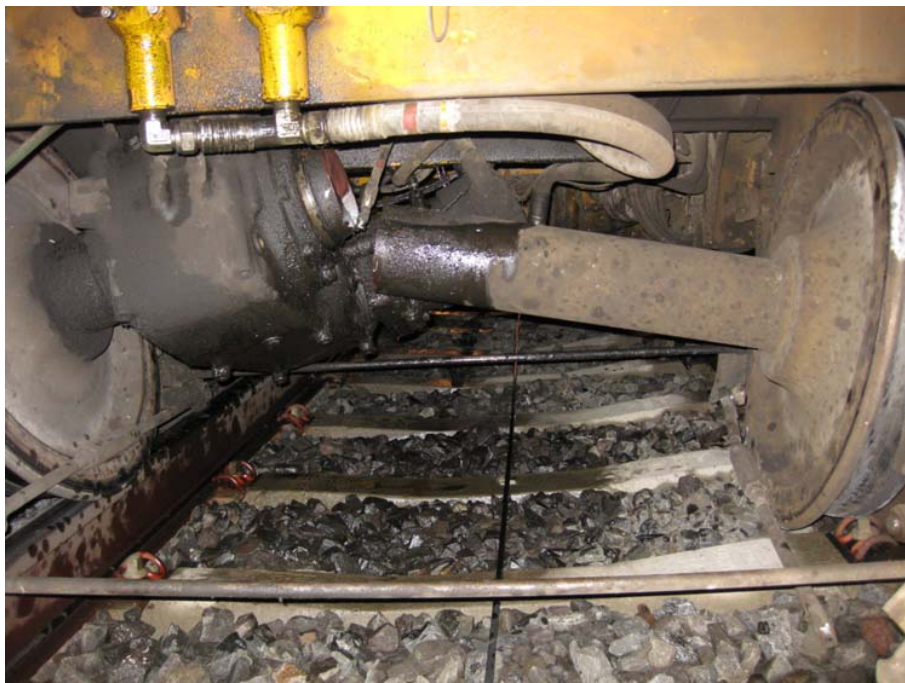
Vista de la rotura del eje en el lugar del suceso (Fuente: Adif)
