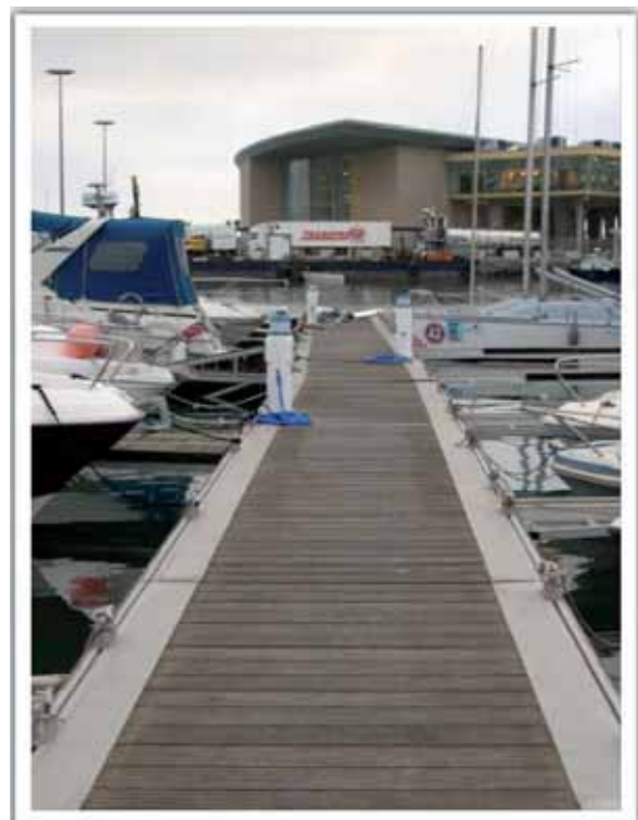
Figura 8. Estado en el que quedó el pantalán
