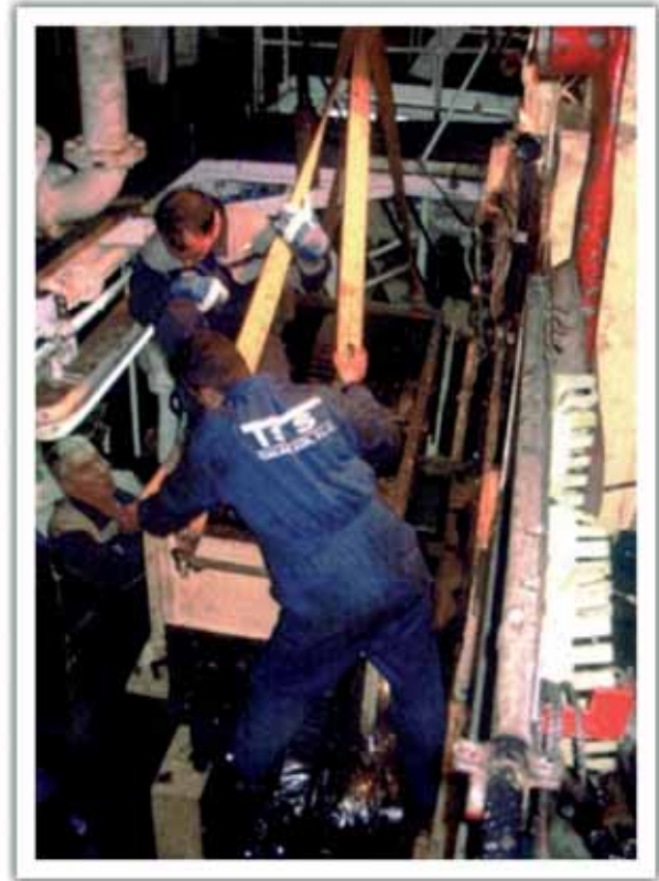
Figura 8. Desmontaje del damper
