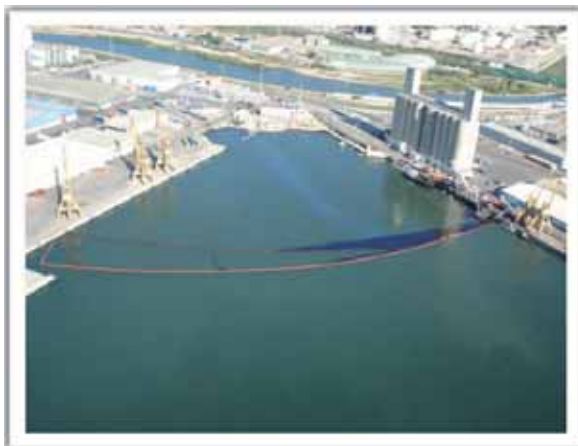
Figura 39. Disposición de las barreras de contención
