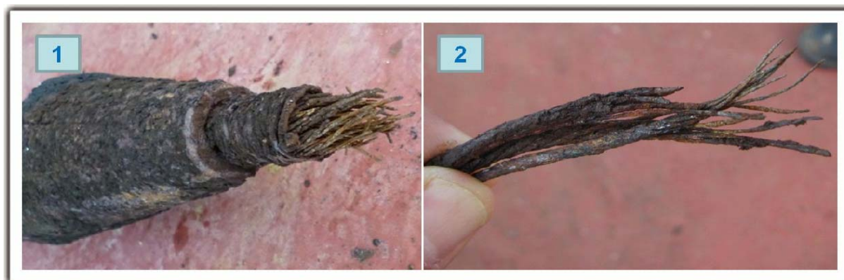
Figura 6. Estado que presentaba el cable en la zona de rotura tras producirse el accidente
