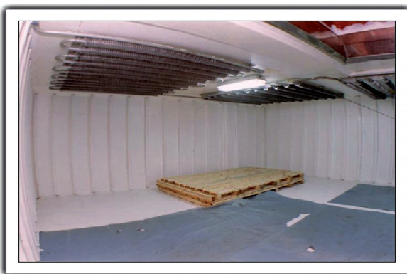
Figura 7. Bodega de carga
