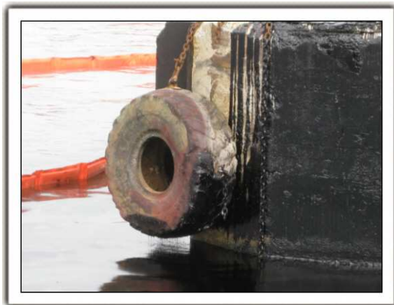
Figura 6. Defensa contra la que se apoyó el buque tanque de fuel oil n.º 3 de babor.
