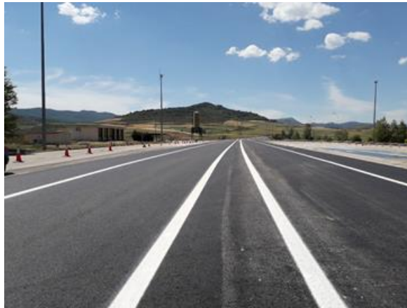
Restitución de la plataforma de circulación en la antigua playa de peaje de Ameyugo
