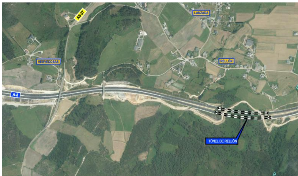
Túnel de Rellón
