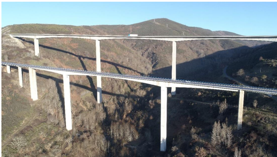
Viaducto de Ruitelán (en primer término)
