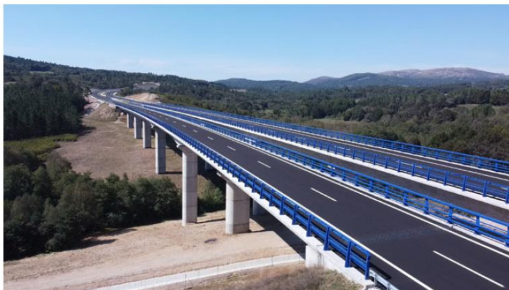
VIADUCTO RÍO BÚBAL
