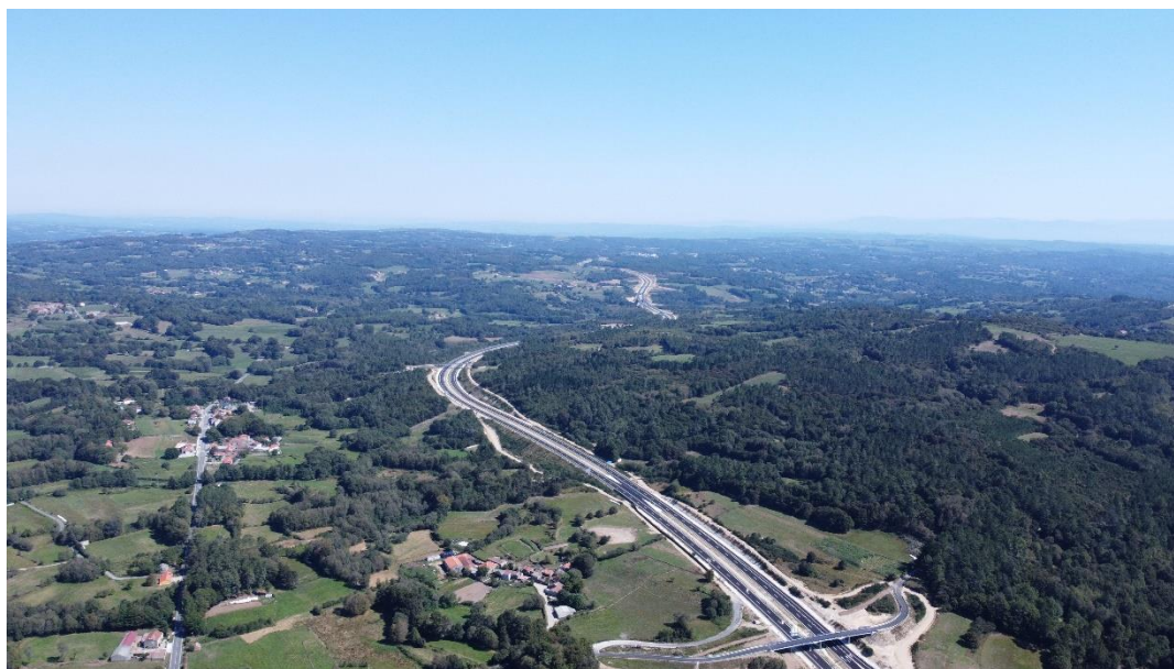
Vista general de la autovía, hacia Lugo
