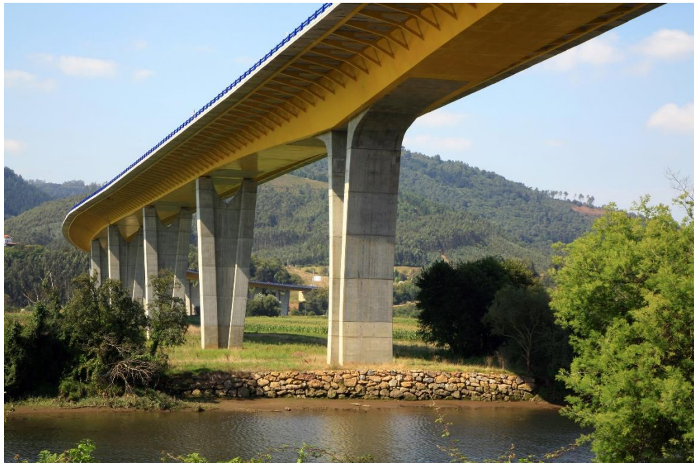
Viaducto de la Autovía del Cantábrico sobre el río Nalón
