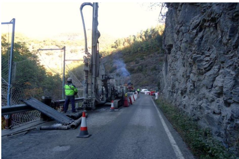
Cimentación de voladizos mediante micropilotaje.
