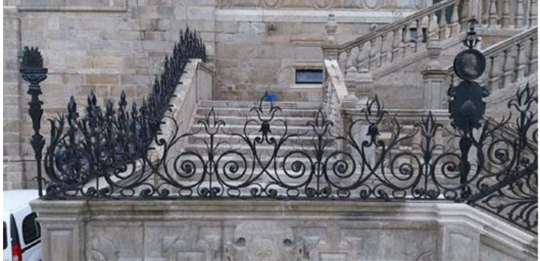
Estado final de las obras en la Cripta
