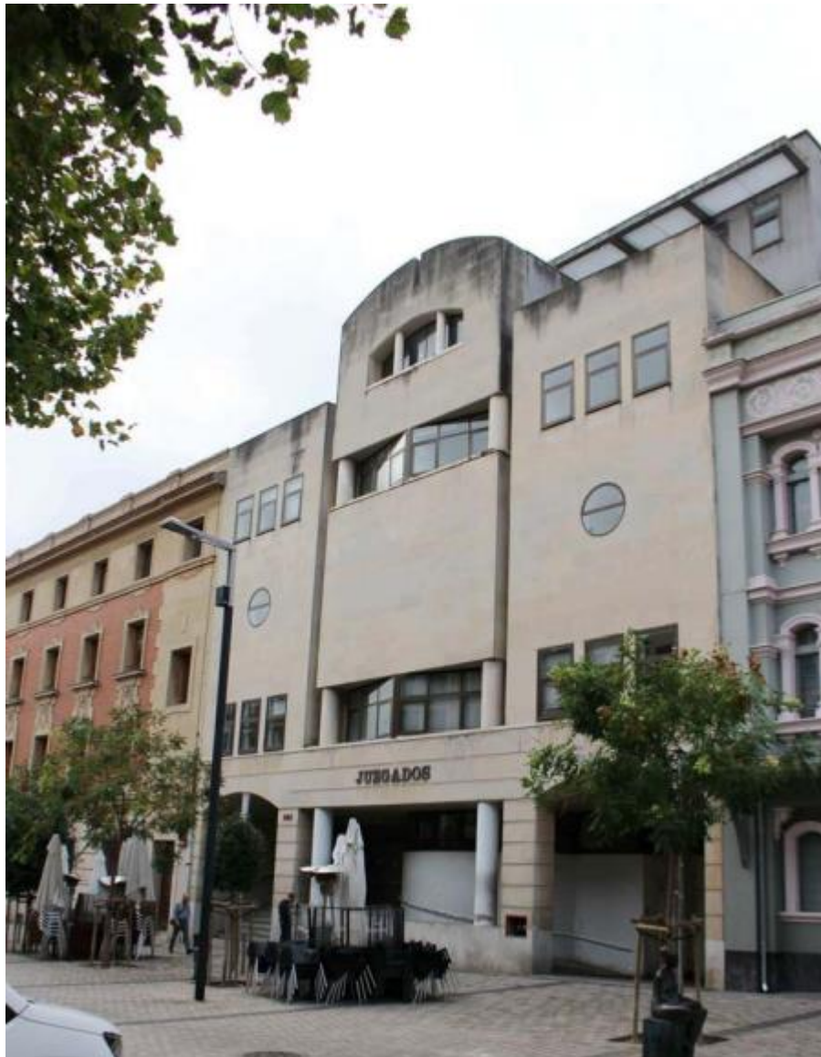
Inmueble de actuación con el edificio de los Juzgados a derribar.
