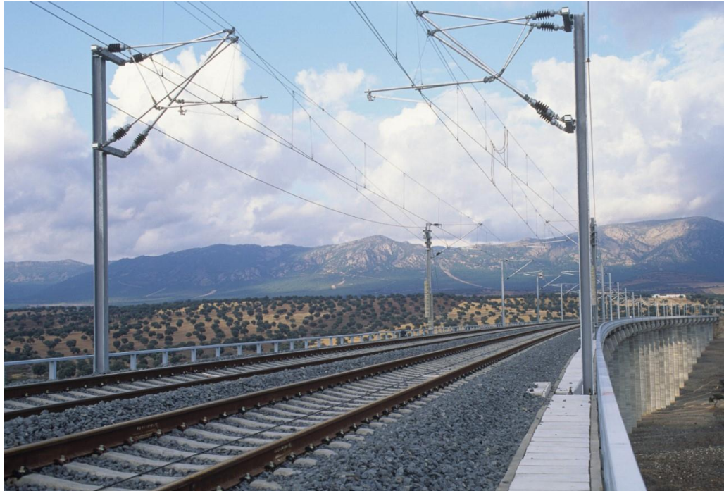
Tramo de la LAV Madrid-Sevilla
