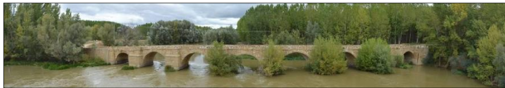
Tramo III (Objeto de la rehabilitación)
