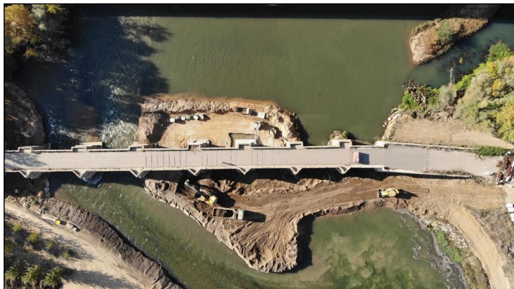
Fase de obras
