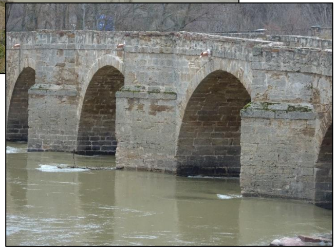
Estado del puente rehabilitado
